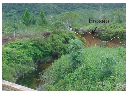
Foto 4 - Erosão fluvial em depósito de colúvio de baixada. Município de Cananéia - SP.
