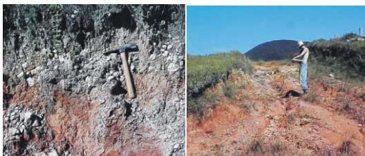
Foto 16 e 17 - Vista do perfil evidenciando a existência de seixos, possivelmente relacionados à formação Pariquera-Açu. Presença de sulcos erosivos em área de acesso à estabelecimento rural. Município de Cananéia - SP
