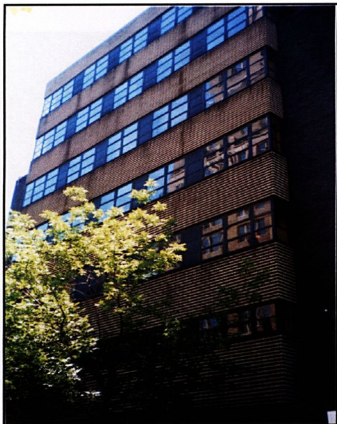
Prédio da New School for Social Research em Nova York, E.U.A.. onde Reich trabalhou entre janeiro de 1940 e maio de 1941.
