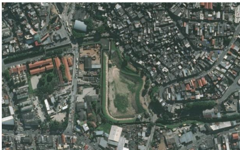
Figura 21 - Foto do Reservatório Parque Pinheiros
