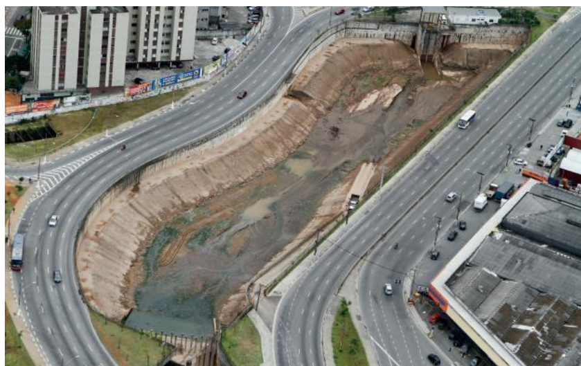
Figura 22 - Foto do Reservatório Eliseu de Almeida
