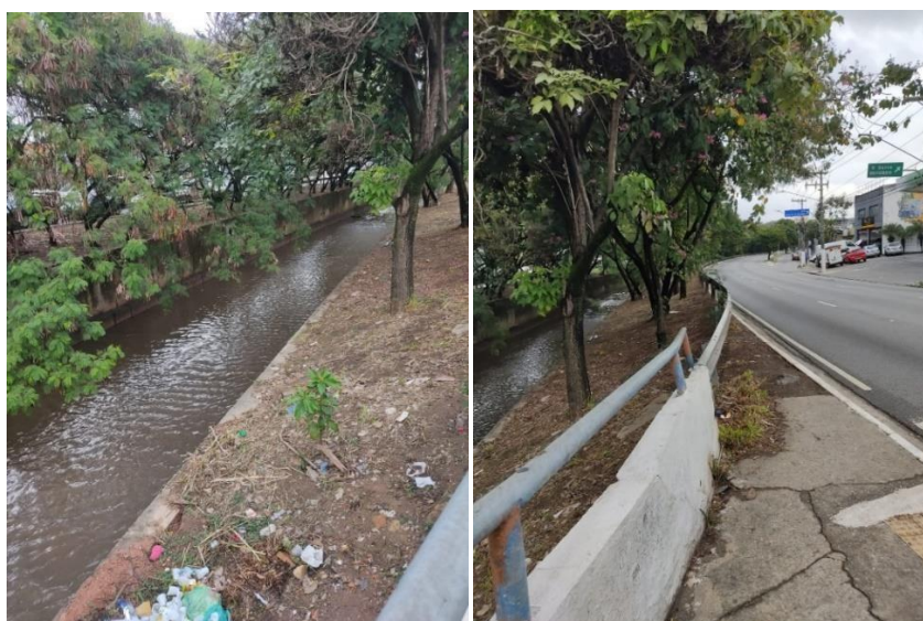
Figura 8 - Canalização do córrego do Jaguaré
