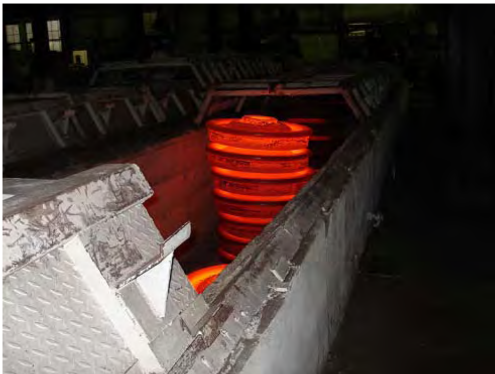
Figura 38 – Fossa de resfriamento controlado.
