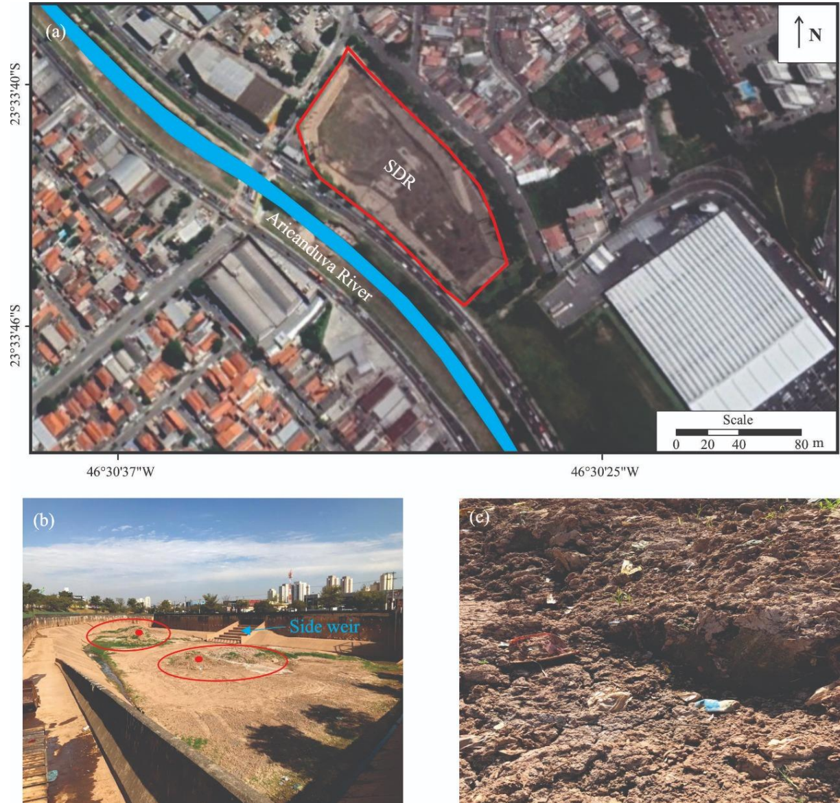
Figura 4: Vista aérea do SDR Jardim Arize, identificado com linha vermelha contínua (Google Earth Pro, 2020) (a), localização dos pontos de coleta (b) e destaque para o sedimento e os resíduos acumulados (c)
