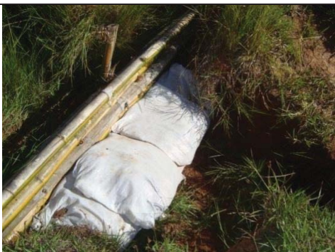
Figura 17. Disposi  o dos sacos de r fia   montante da barreira de conten  o na eros  o 2.
