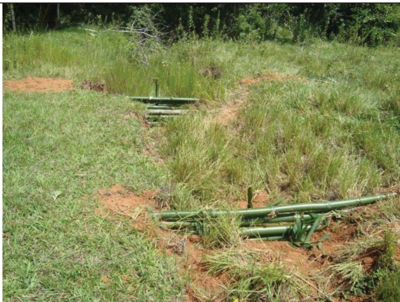
Figura 14. Detalhe final da montagem das barreiras de contenção a montante dos focos erosivos.
