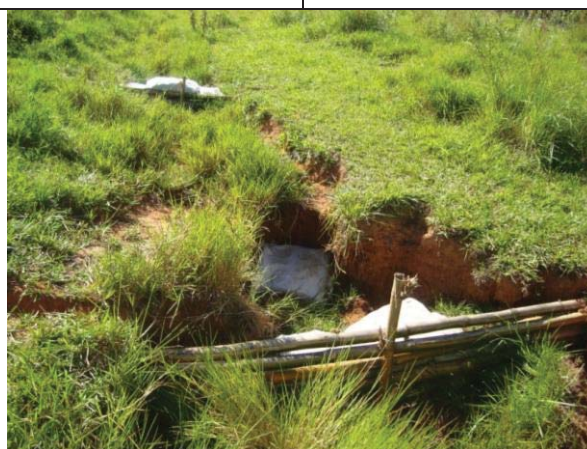
Figura 19. Vista da disposi  o final dos sacos de r fia a montante das barreiras 1 e 2 e na cava erodida.
