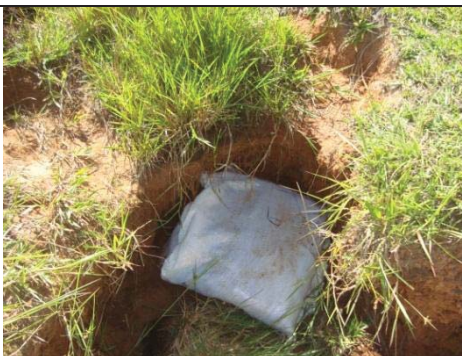
Figura 18. Disposi  o dos sacos de r fia na alcova de regress  o provocada pelo escoamento superficial a montante da barreira de conten  o na eros  o 2.
