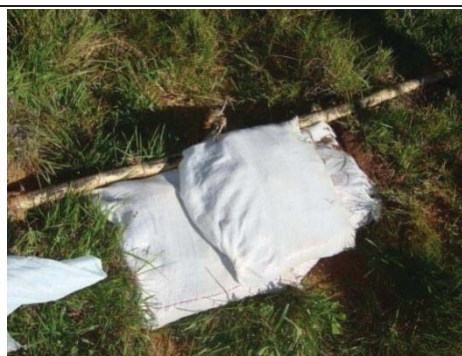
Figura 16. Disposi  o dos sacos de r fia   montante da barreira de conten  o na eros  o 1.
