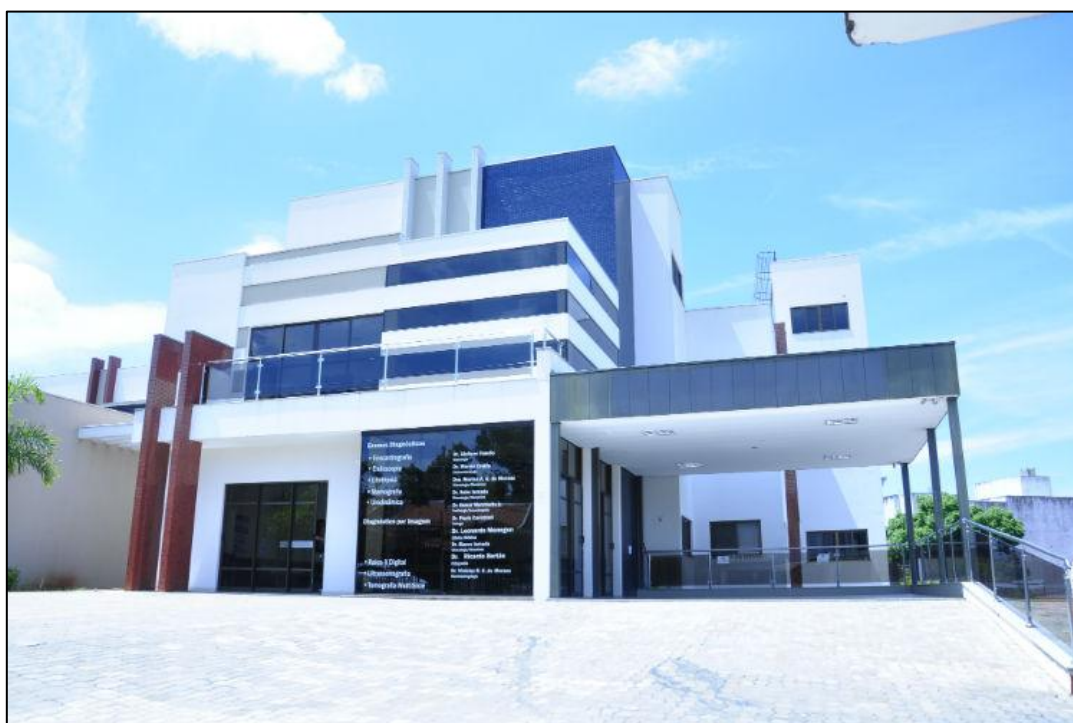
Foto 1: Fachada do Hospital Iamada.
