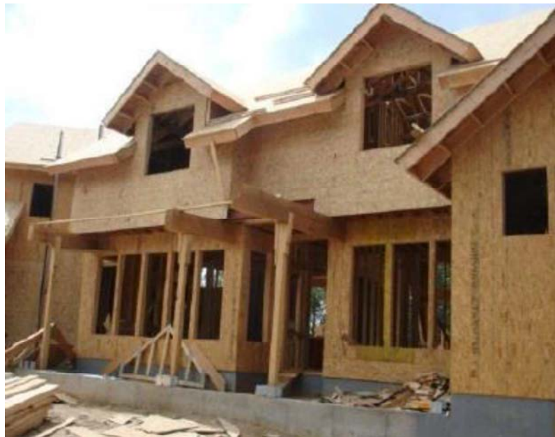
Figura 9 – Estrutura em Wood Frame
