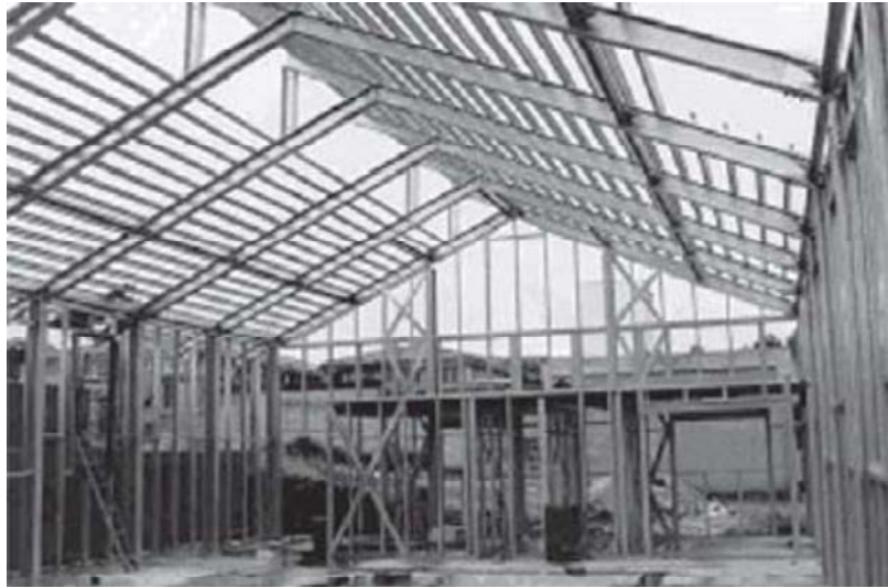
Figura 17 – Cobertura metálica de Light Steel Frame
