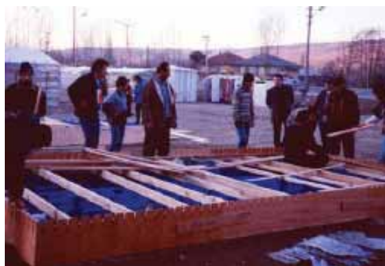
Figura 33: Base da Paperlog House feita com engradados plásticos e madeira de pallets . Fonte: FREITAS (2009)
