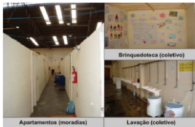
Figura 27: Imagens do abrigo provisório Itoupava Seca, adaptado em edifício escolar para vítimas das enchentes e dos desmoronamentos ocorridos em Santa Catarina, em 2008. Fonte: OBENAUS (2009)
