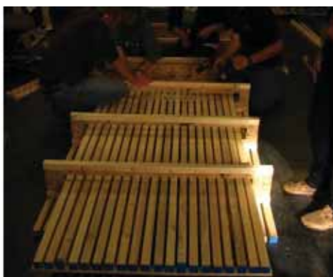
Figura 53: Construção da rampa de madeira de pallets . Fonte: http://www.dosomething.org/
