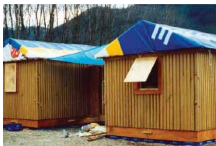
Figura 35: Cobertura da Paperlog House feita com lona plástica. Fonte: FREITAS (2009)
