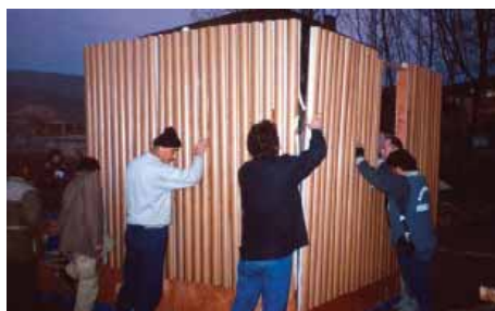
Figura 34: Placas de parede da Paperlog House feitas com tubos de papel. Fonte: FREITAS (2009)
