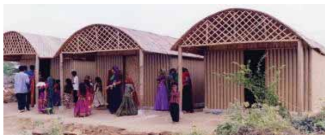
Figura 37: Adaptação na Paperlog House na Índia: varanda remete à cultura e a tradição local. Fonte: http://www.shigerubanarchitects.com/
