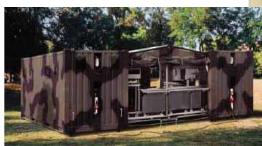
Figuras 19 e 20: Abrigo desenvolvido pelo exército americano, chamado COGIN – desmontado para transporte e montado in loco. Fonte: FREITAS (2009)
