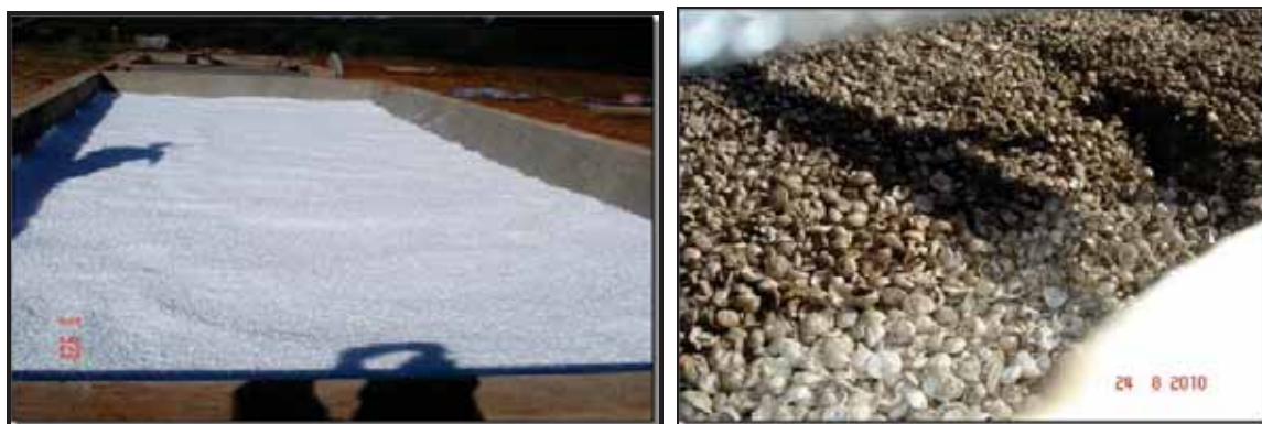
Figura 20. Vista do filtro anaeróbio de fluxo ascendente com o meio suporte em EPS com forma geométrica côncava, antes e durante a operação.
