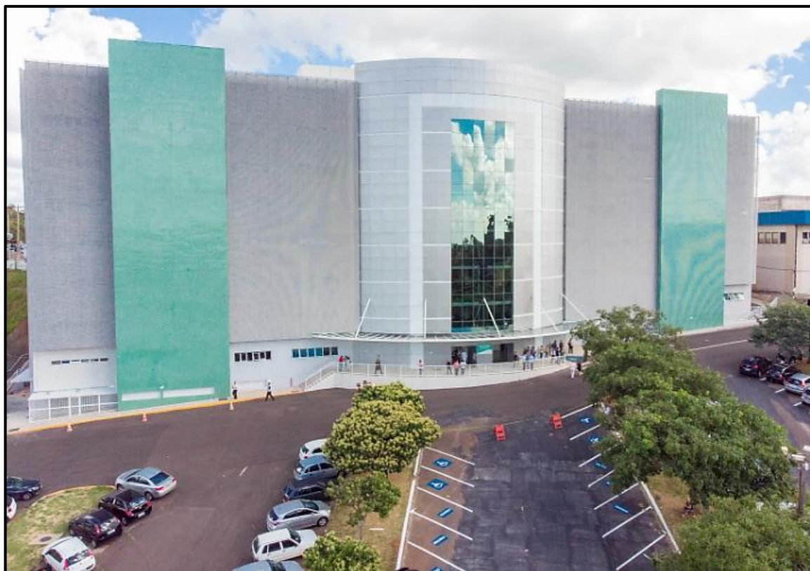
Fig. 15: Prédio de ambulatórios do HC.
