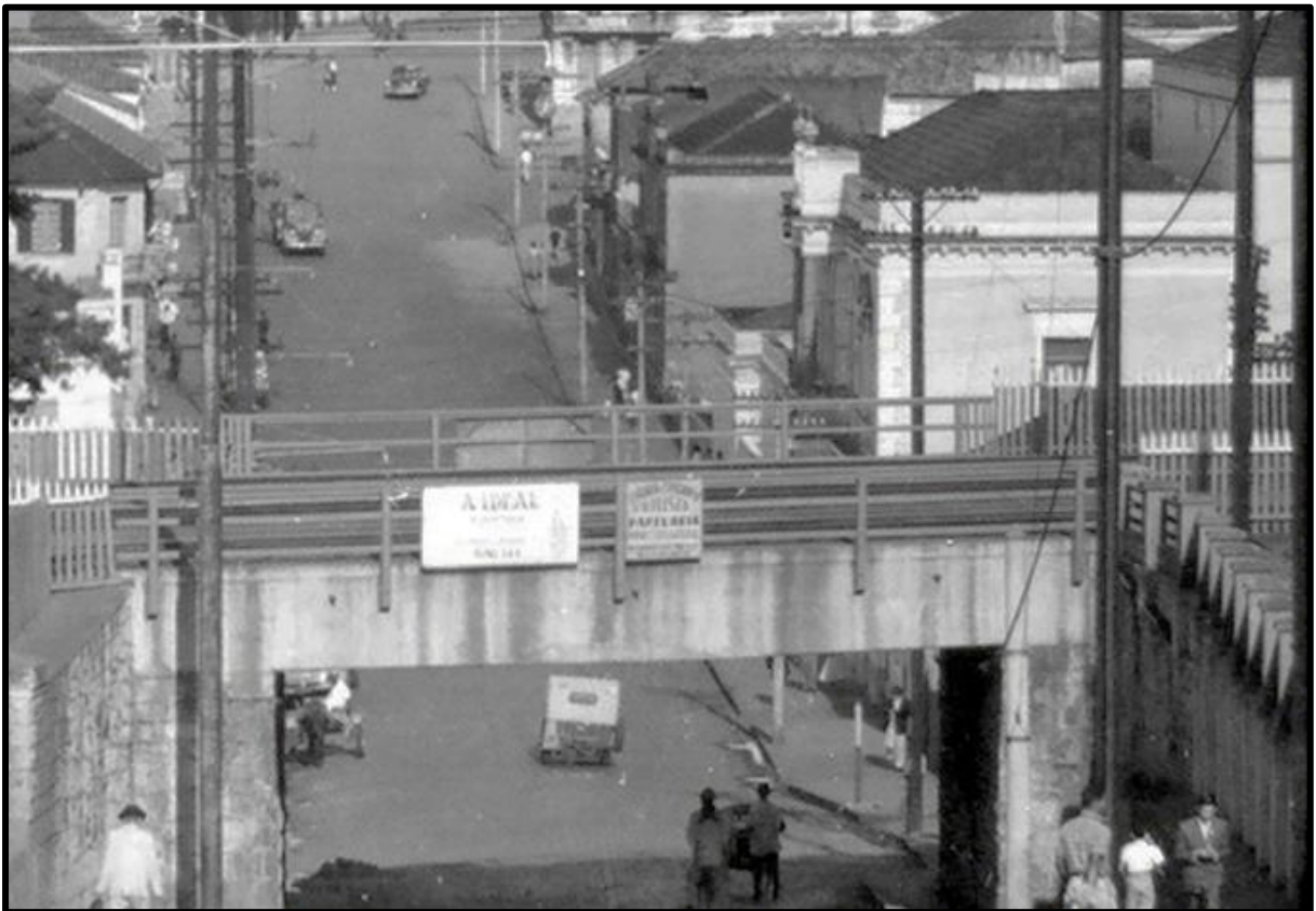
Fig. 3A: Vista do pontilhão entre a Avenida Floriano Peixoto e Rua Major Matheus.
