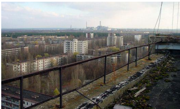
Figura 22 – Instalações abandonadas ao redor de Chernobyl
