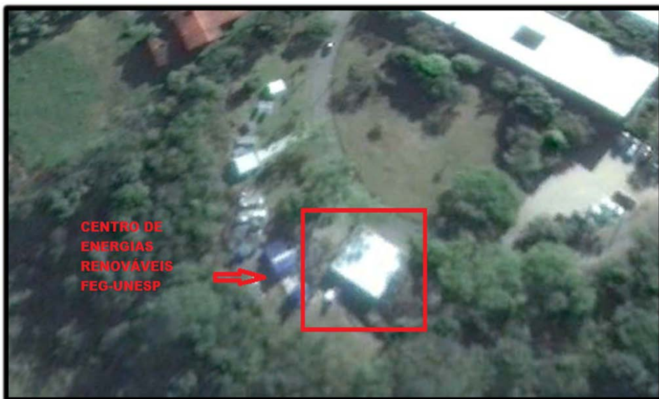
Figura 5 - Foto Aérea do Centro de Energias Renováveis.
