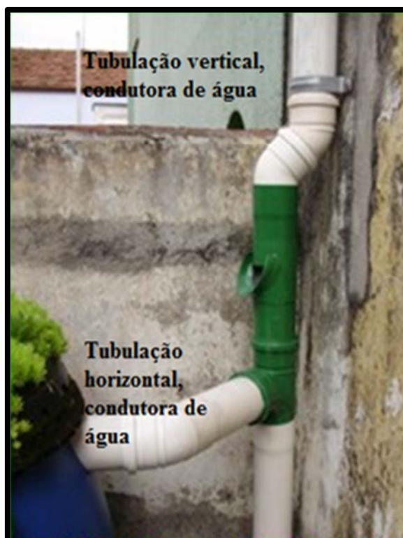
Figura 8 - Exemplo de tubulação com canos de PVC
