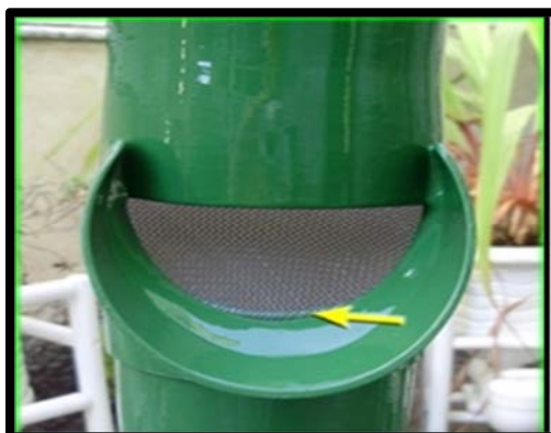
Figura 11 - Exemplo de filtro simples
