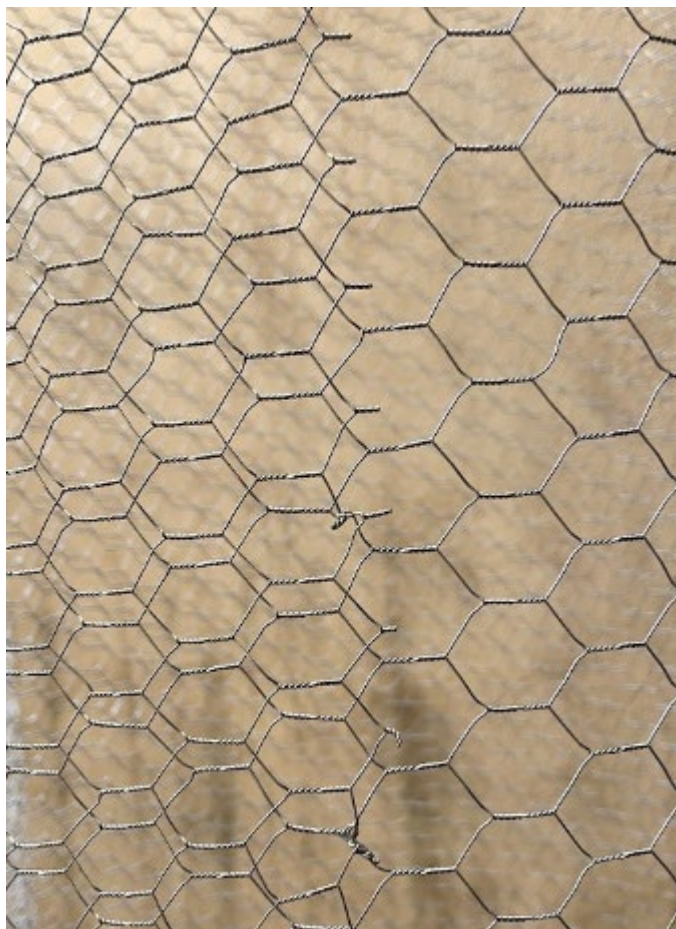
Figura 4 – Detalhe da malha da tela galvanizada utilizada na estrutura.
