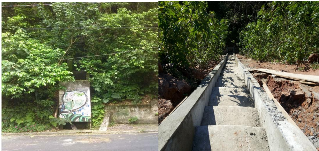
Figura 26 - Escada hidráulica em detalhe
