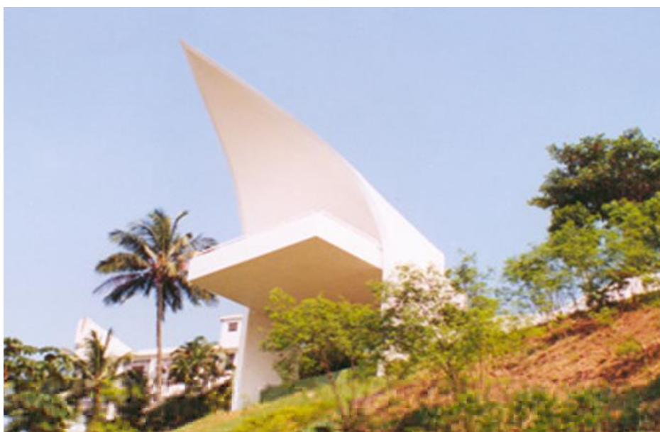
Figura 22 - Erosão do solo residual à direita
