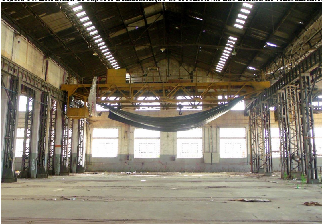
Figura 10. Estrutura de suporte à manutenção de locomotivas não inclusa no tombamento.
