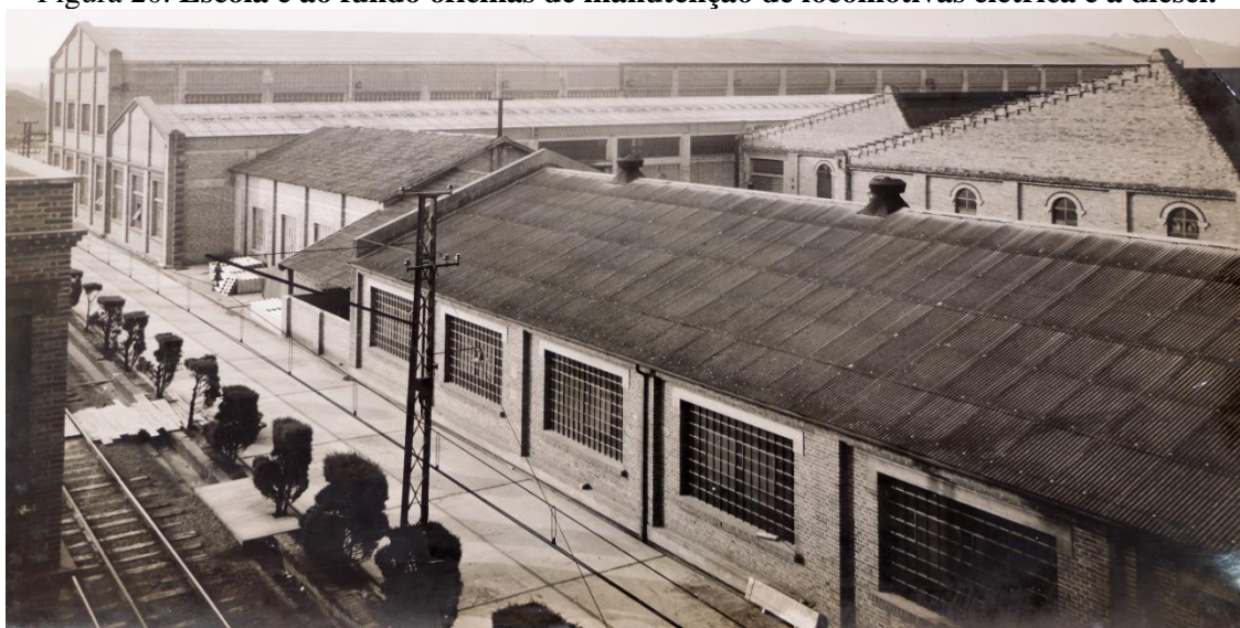
Figura 20. Escola e ao fundo oficinas de manutenção de locomotivas elétrica e a diesel.
