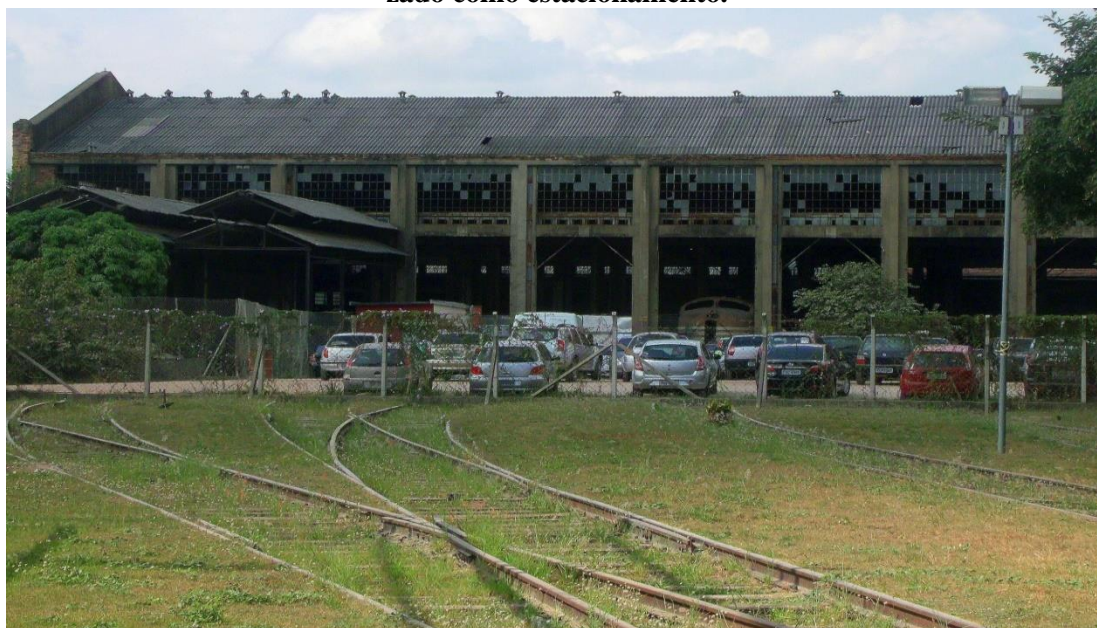
Figura 18. Pátio de manutenção de locomotivas, atualmente bloqueado por grades e utilizado como estacionamento.
