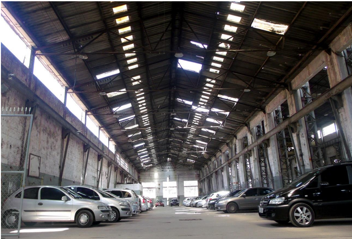
Figura 17. Antiga oficina de manutenção de locomotivas elétricas e a diesel, atual estacionamento.
