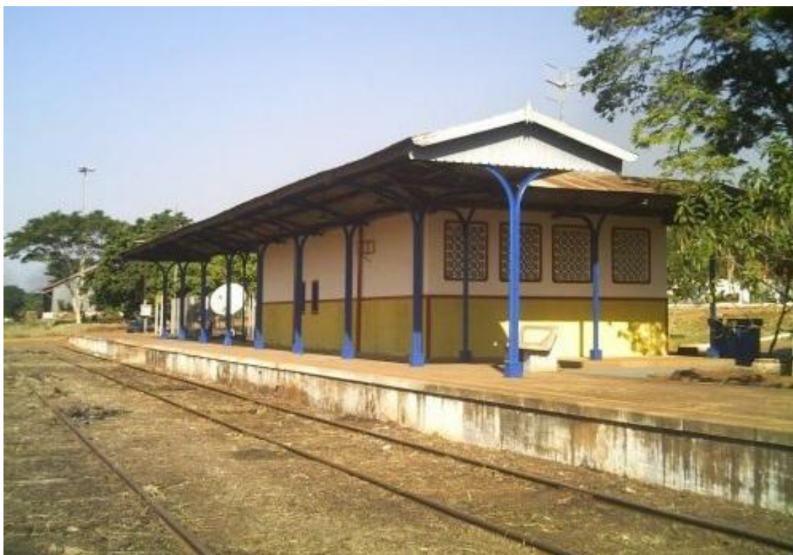
Figura 8 – Estação ferroviária de Panorama (SP)
