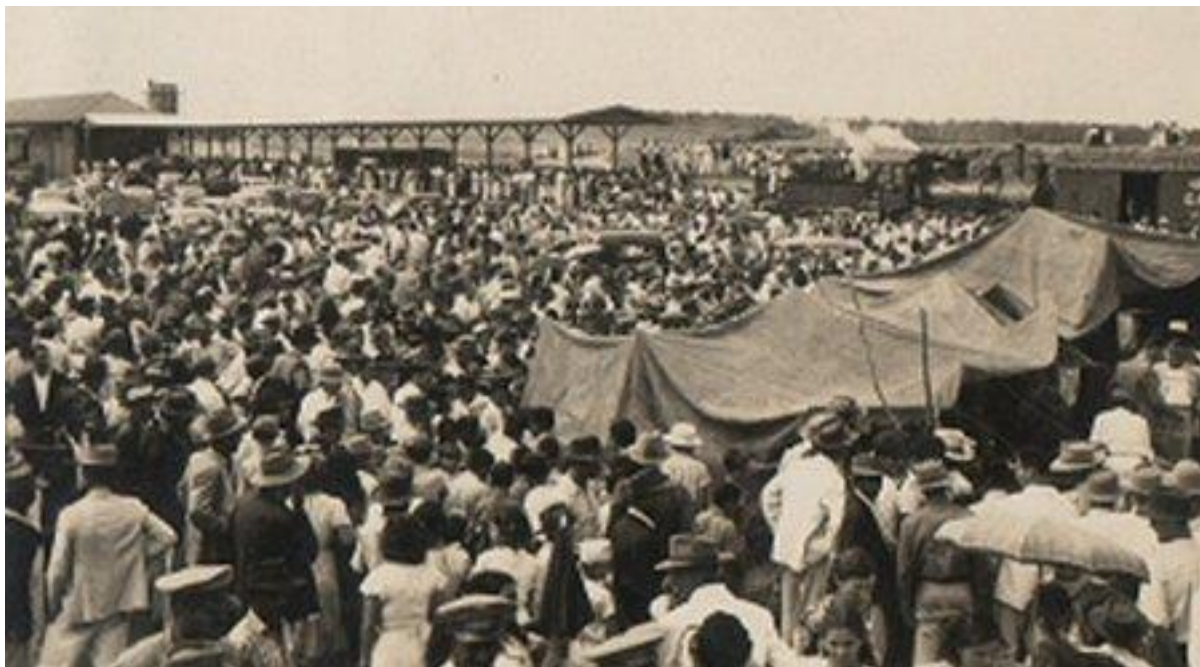
Figura 6 – Estação ferroviária de Adamantina (SP)
