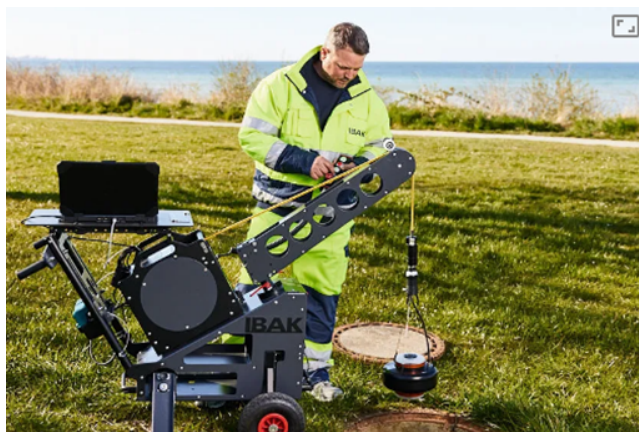
Figura 8 – Robô de inspeção Panoramato.
