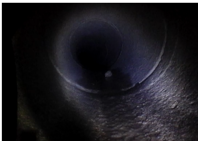
Figura 27 – União dos tubos de concreto armado.
