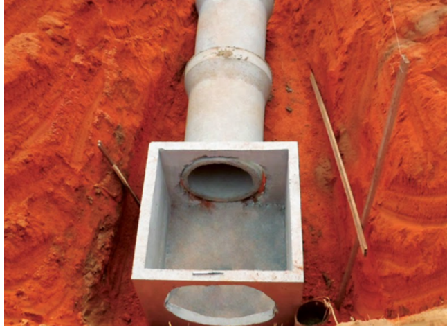
Figura 2 – Montagem de tubulação para sistemas de drenagem.
