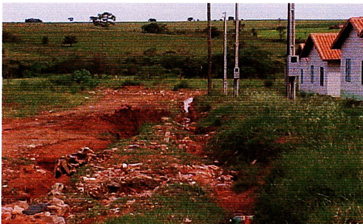
FIGURA 46 – Local 04 - empreendimento “BIRIGUI C”, data: 11/01/2001.
