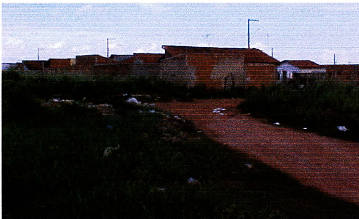
FIGURA 29 – Local 02 - empreendimento “BIRIGUI C”, data: 18/12/2001.
