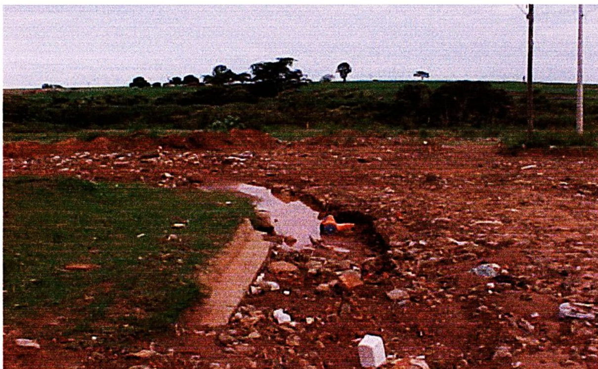
FIGURA 35 – Local 07 - empreendimento “BIRIGUI C”, data: 11/01/2001.
