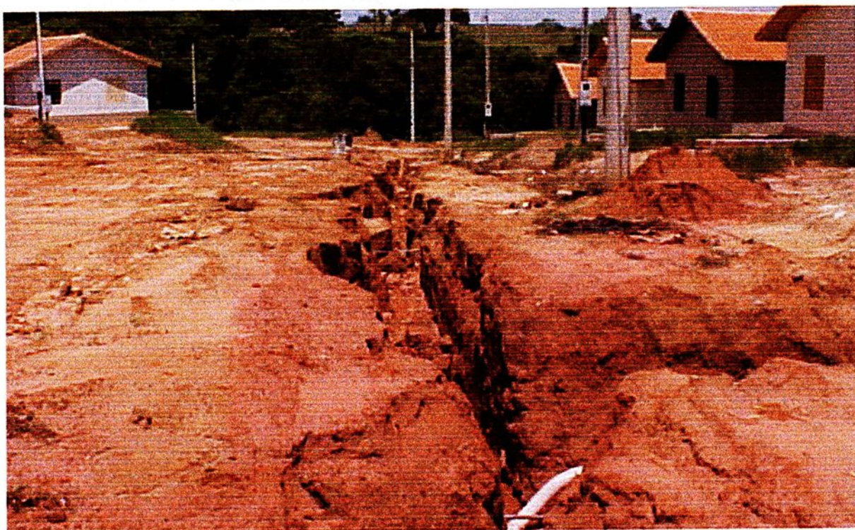
FIGURA 68 – Local 03 - empreendimento “Guaraçai E”, data: 19/12/2001.
