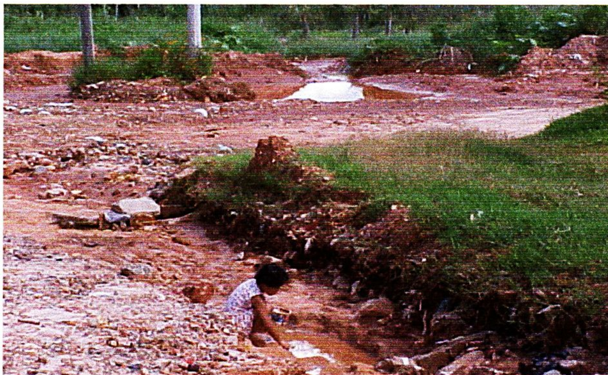
FIGURA 13 – Local 07 - empreendimento “BIRIGUI C”, data: 18/12/2001.
