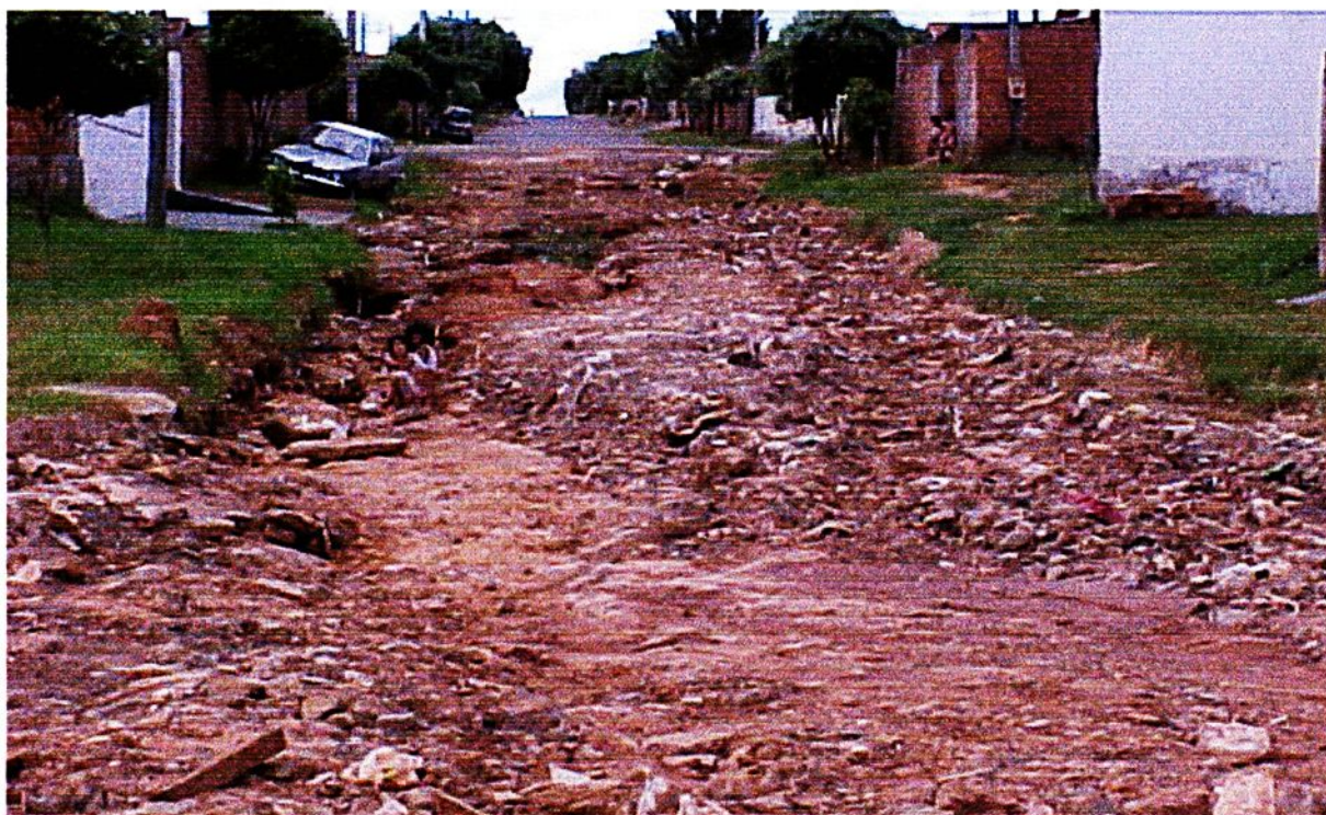
FIGURA 34 – Local 08 - empreendimento “BIRIGUI C”, data: 18/12/2001.
