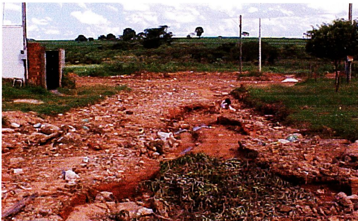
FIGURA 36 – Local 07 - empreendimento “BIRIGUI C”, data: 18/12/2001.
