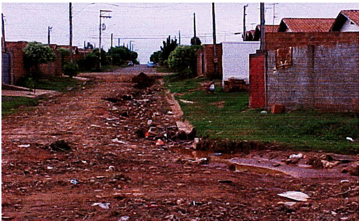
FIGURA 33 – Local 08 - empreendimento “BIRIGUI C”, data: 11/01/2001.
