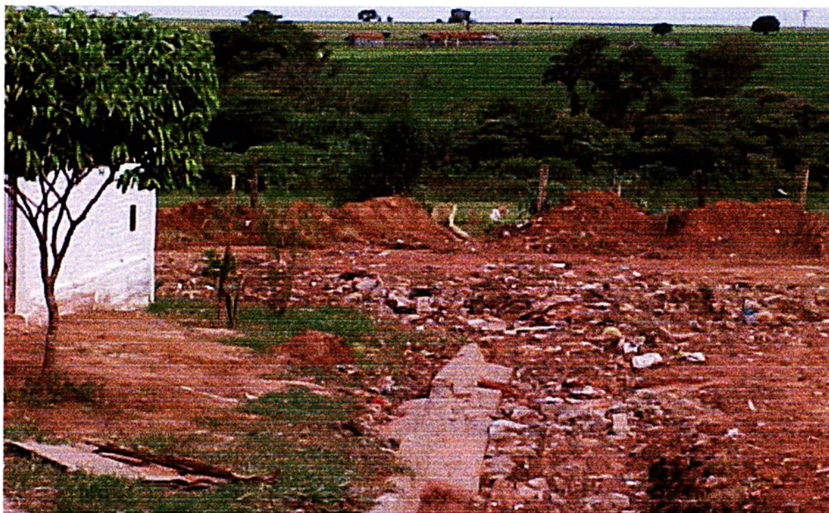
FIGURA 48 – Local 05 - empreendimento “BIRIGUI C”, data: 11/01/2001.
