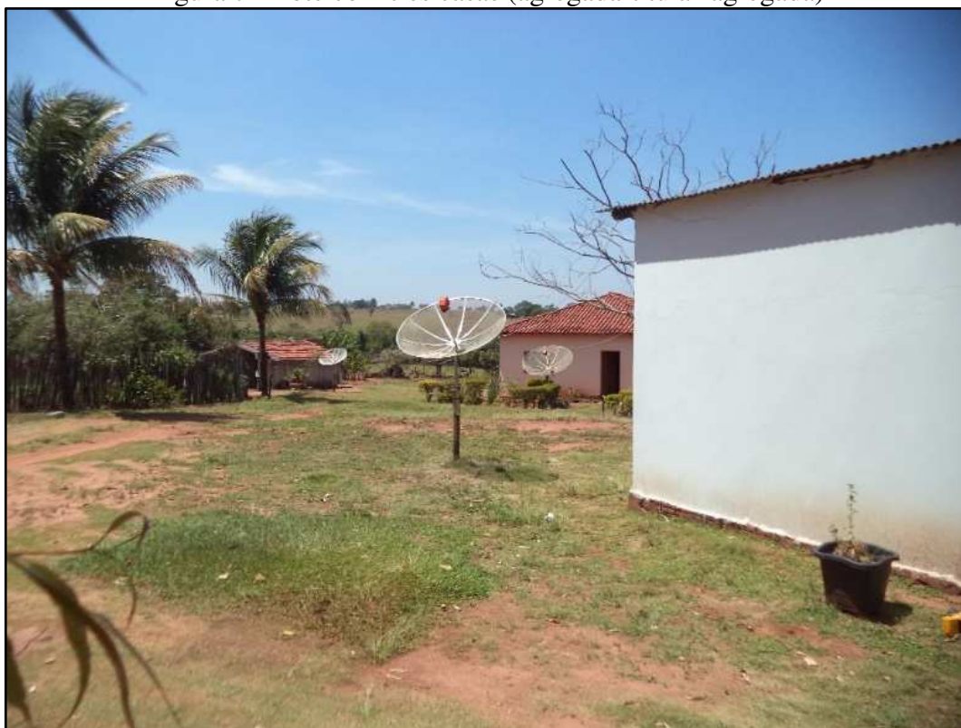
Figura 7 - Lote com três casas (agregada-titular-agregada)
