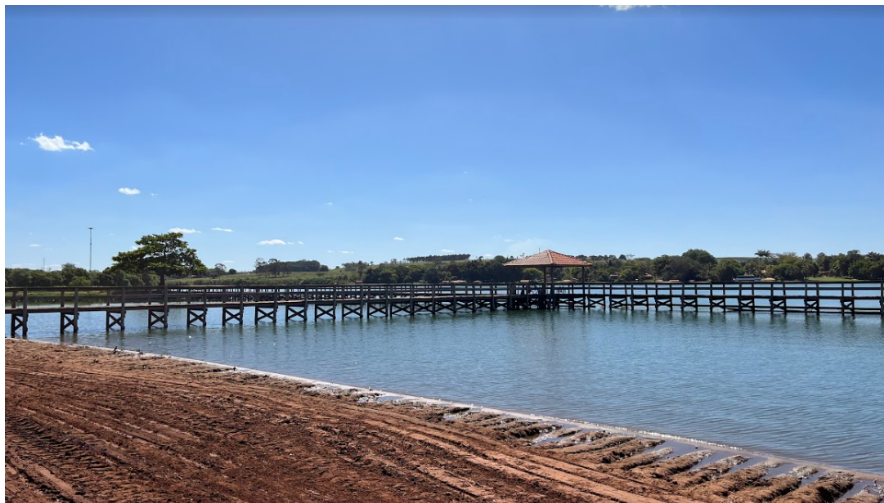
Figura 10 - Foto do dia na visita técnica em Arealva.
