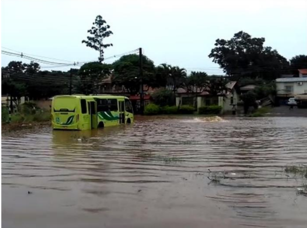
Alagamento sobre canalização fechada do córrego Poty - 05/04/2019
