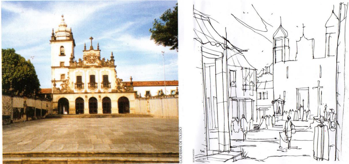
Figura 2 - Largo (Praça ou Adro) colonial configurado pela igreja e pelas edificações em seu entorno – Adro da igreja de São Francisco de Assis, João Pessoa.
