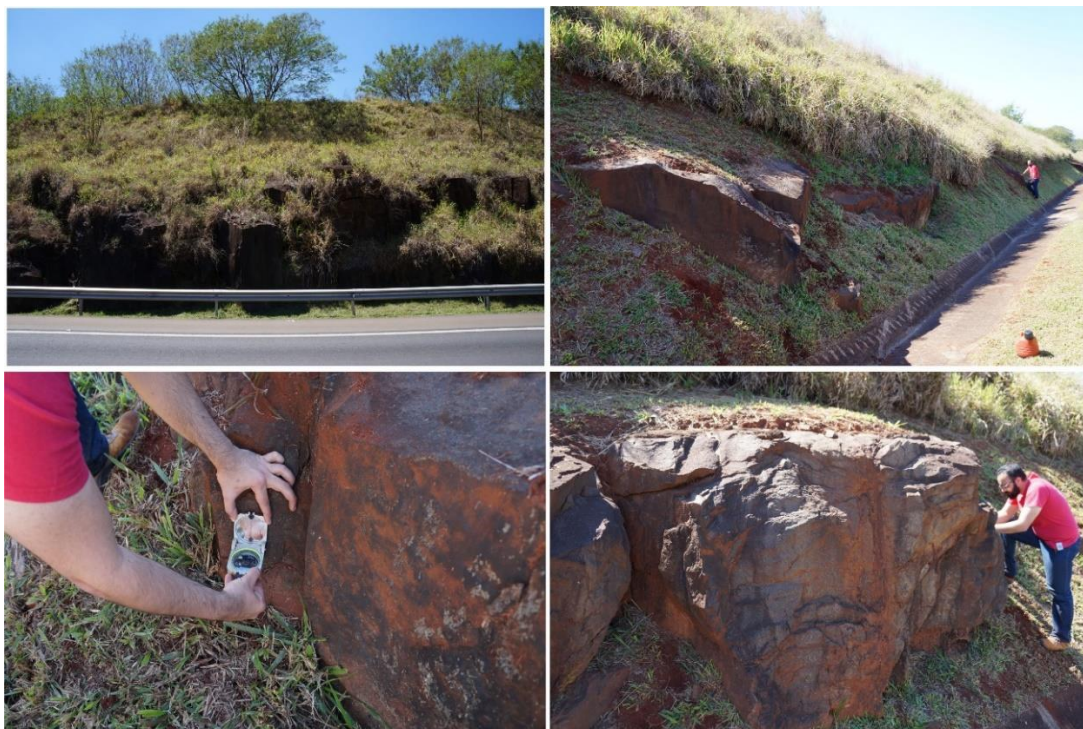
Figura 51: Aspecto geral do afloramento de diabásio em corte de estrada e detalhes para as medidas estruturais.
