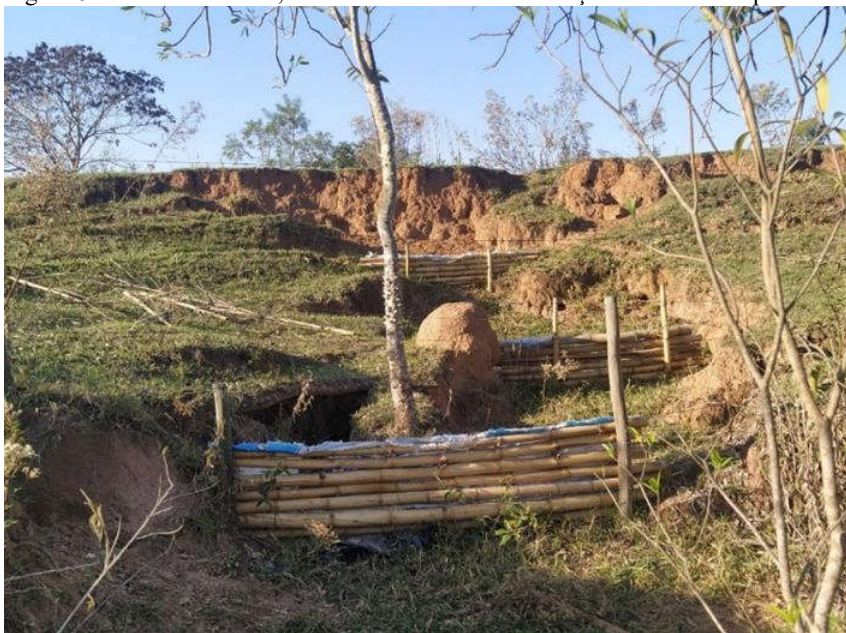
Figura 8 - APA do Timburi, Presidente Prudente/SP. Paliçadas de bambu aplicadas na propriedade do Sr. Luís
