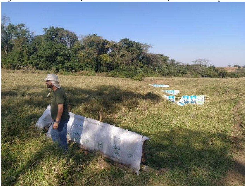
Figura 4 - APA do Timburi, Presidente Prudente/SP. Paliçadas de bambu aplicadas na propriedade do Sr. José
