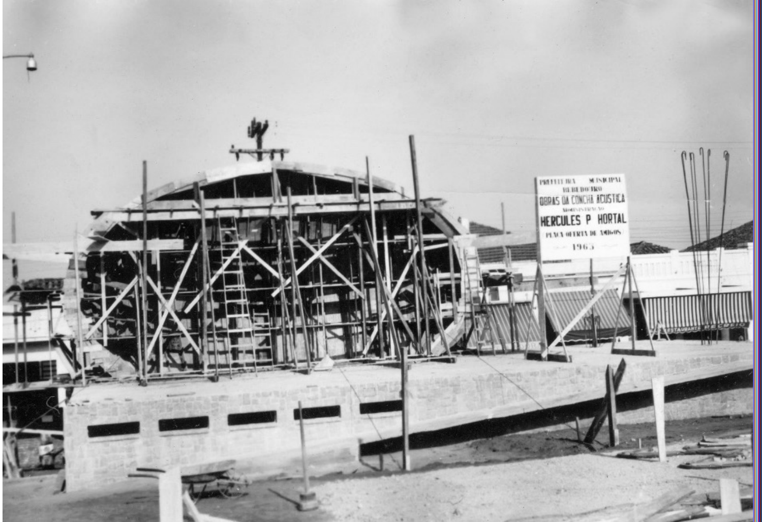
Figura 59 - Fonte Luminosa, Praça Barão do Rio Branco
