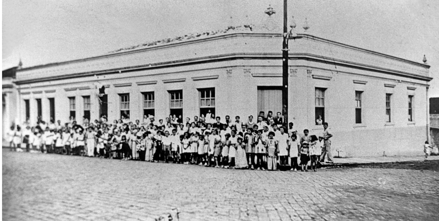
Figura 40 - Associação dos Empregados no Comércio de Bebedouro, esquina das ruas Francisco Inácio com XV de Novembro, fotografia de 1937.
