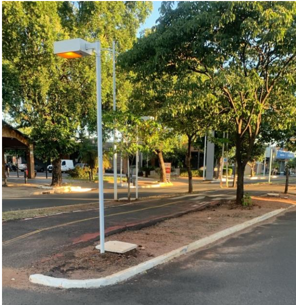
Figura 19 – Trecho de descontinuidade entre a Avenida Brasil Sul e a Avenida Brasil Norte.
