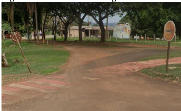
Figura 29 – Trecho com irregularidades.
