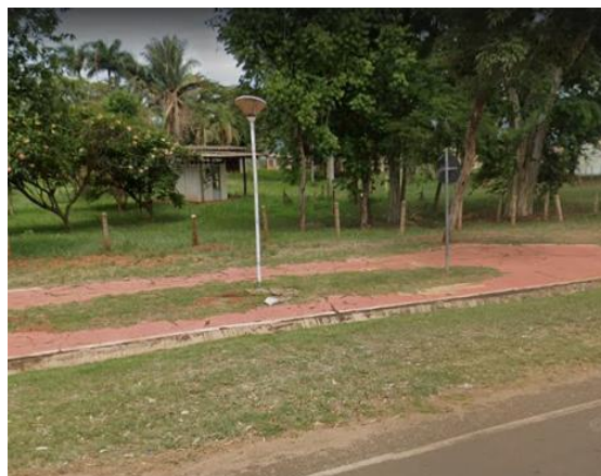
Figura 28 – Trechos com irregularidades.
