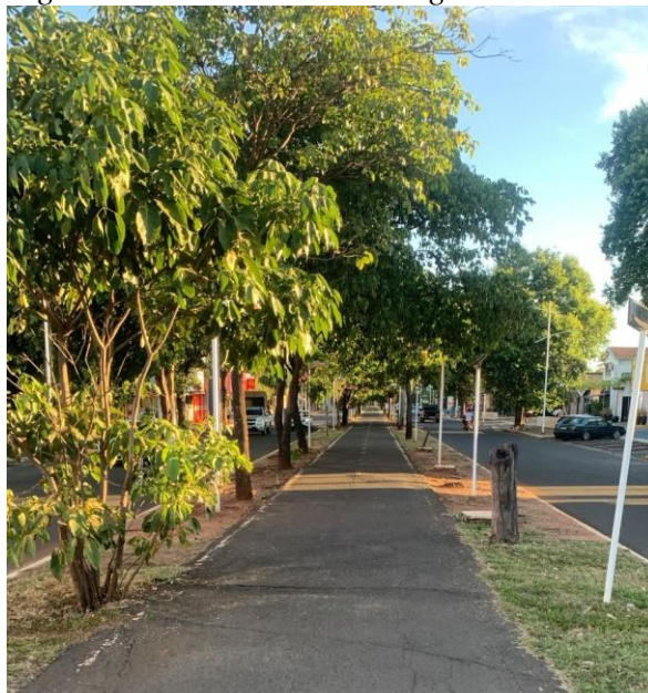
Figura 24 – Trechos com irregularidades..
