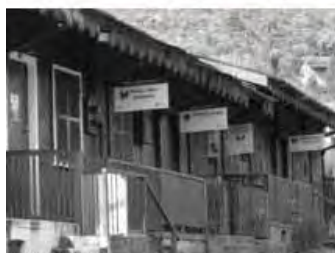
Ateliês Residência Paranapiacaba
