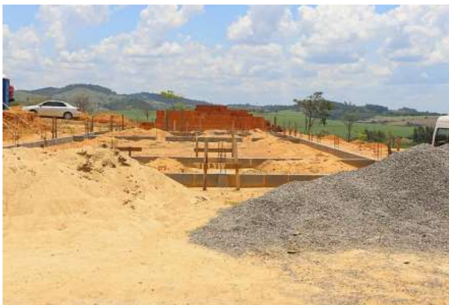
FIGURA 22 - A BASE DA ESCOLA EDUARDO GALEANO EM CONSTRUÇÃO
