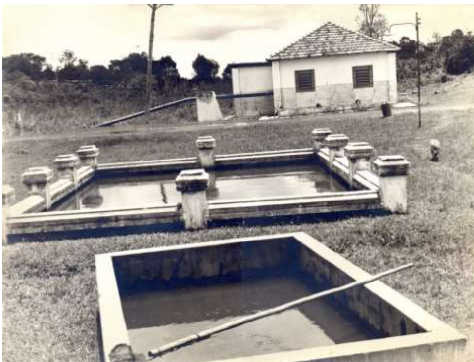
Figura 34 - Captação Vargem Limpa Fonte: DAE BAURU
