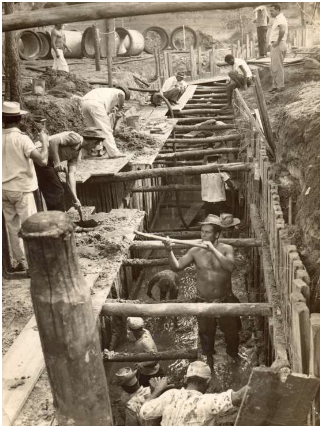
Figura 57 - Construção das adutoras Fonte: DAE BAURU
