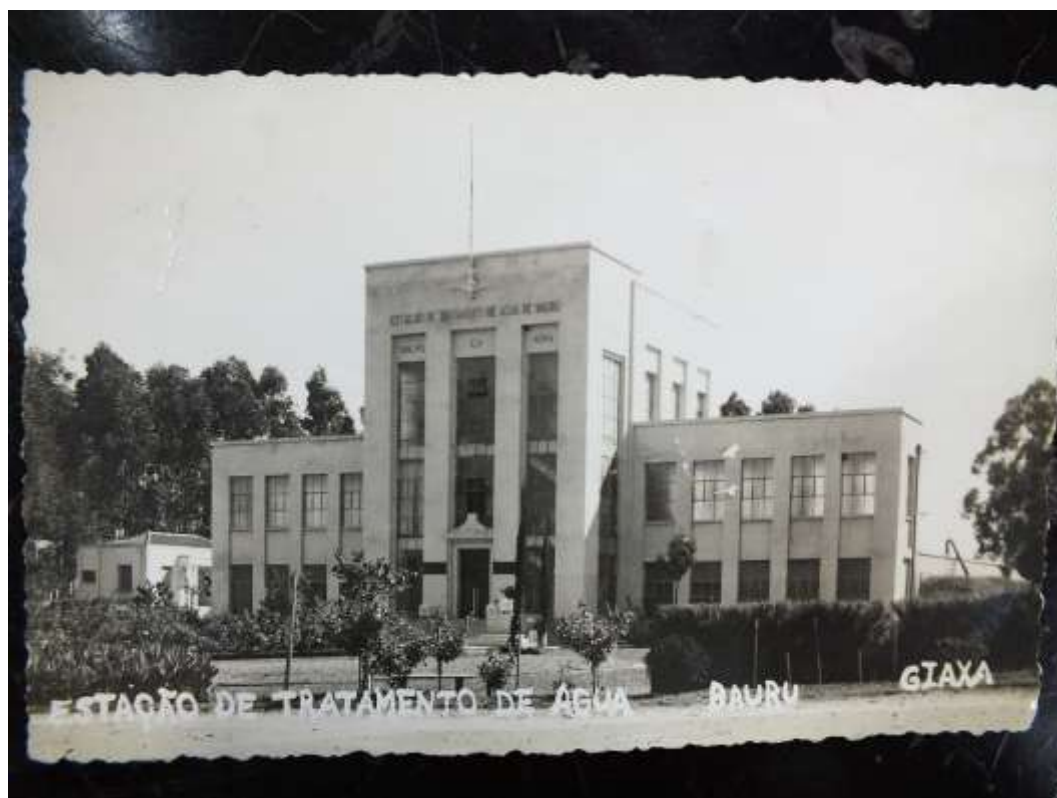
Figura 55 - Prédio da Estação de Tratamento de Água e Esgoto – Eta -1943 Fonte: NHUPIS
