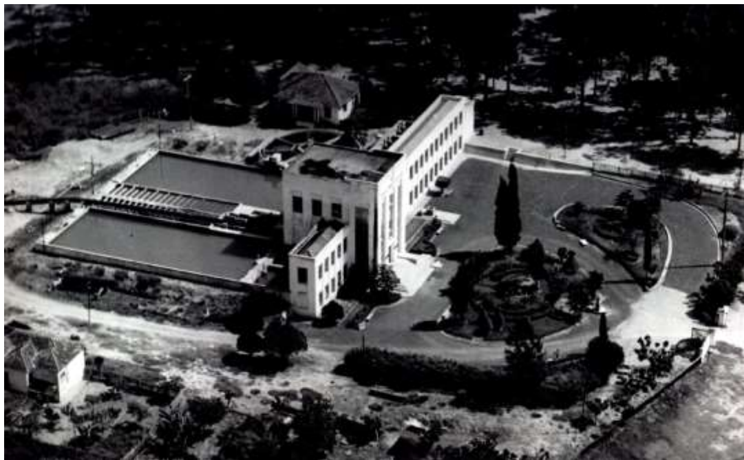
Figura 56 - Estação de Tratamento de água, 1943 Fonte: DAE BAURU
