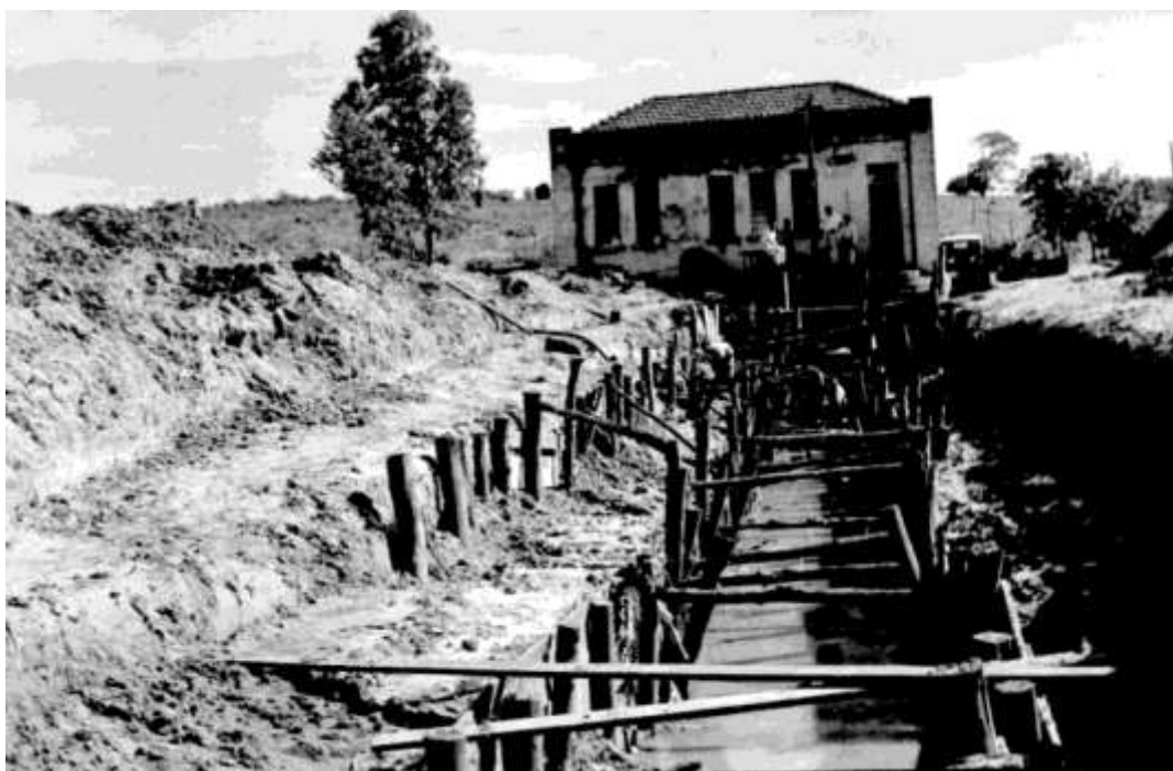
Figura 39 - construção da captação vargem limpa Fonte: DAE BAURU
