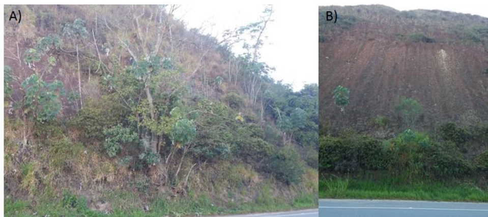
Figura 28- Exemplos de talude de classificação 1. (20/10/2019)
