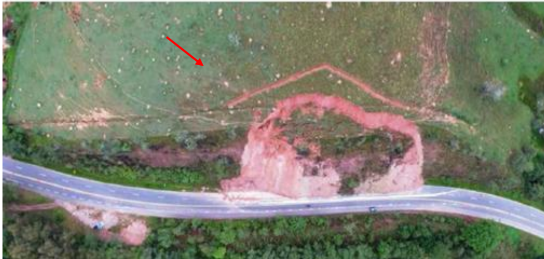
Figura 27 - Indicação da presença de montículos de cupim e formigueiros.
