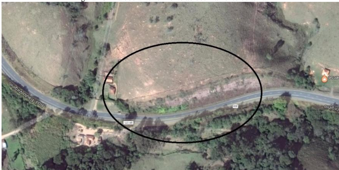
Figura 26 - Talude anteriormente ao deslizamento de terra.
