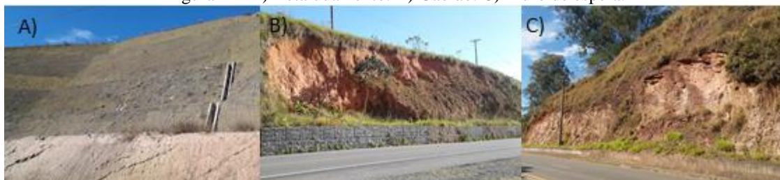
Figura 44- A) Retaludamento. B) Gabião. C) Muro de espera.
