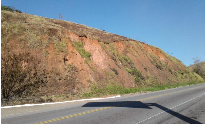
Figura 29- Exemplo de talude de classificação 2. (20/10/2019)
