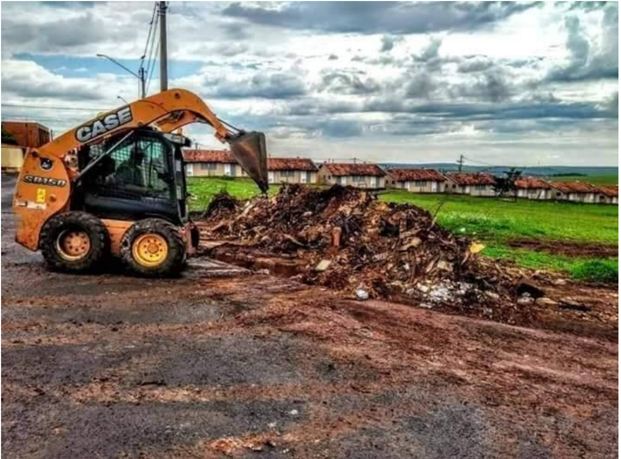
Figura 16 - Limpeza de área verde
