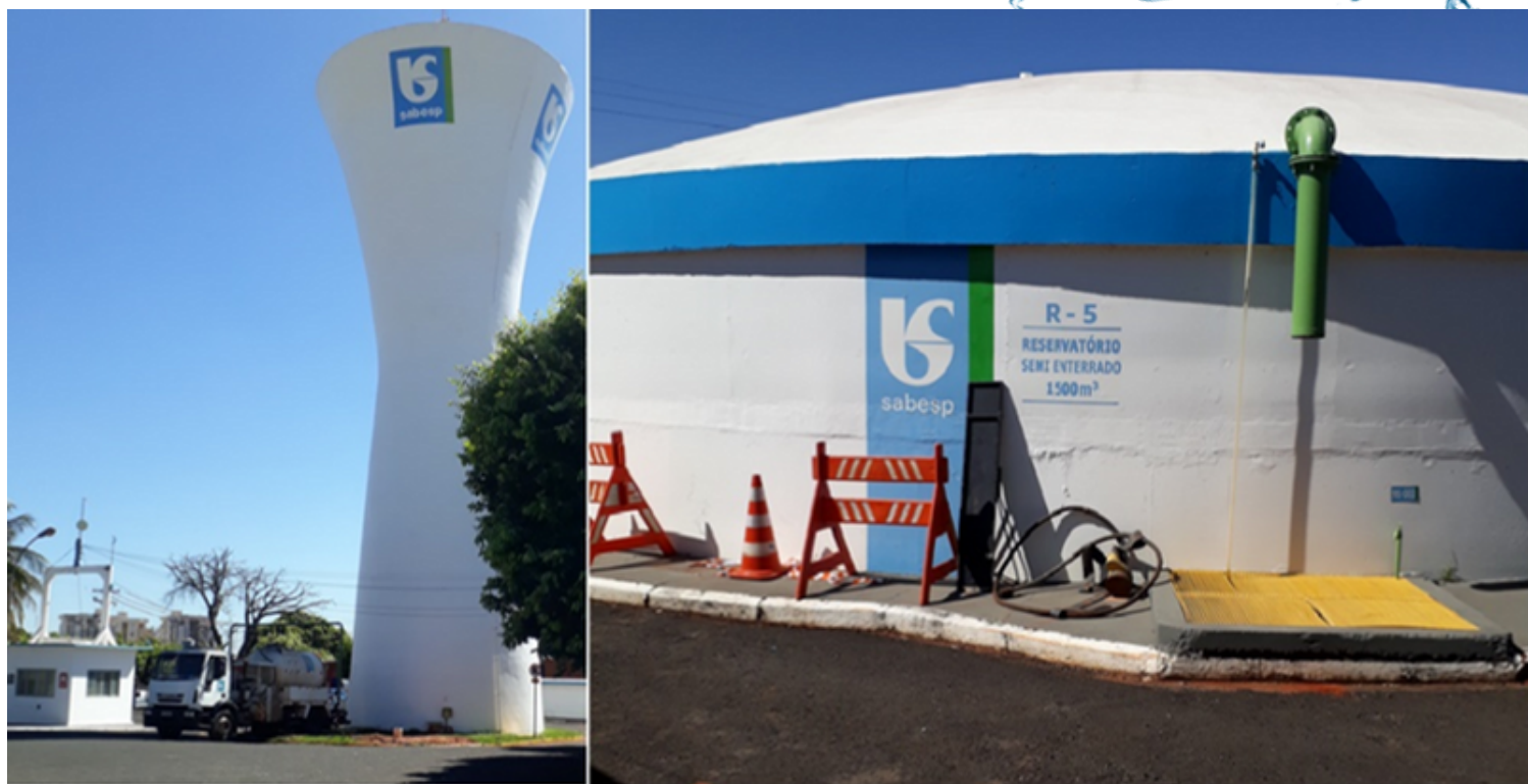
Figura 4 - Reservatório elevado e semi-enterrado da Sabesp de Fernandópolis - SP
