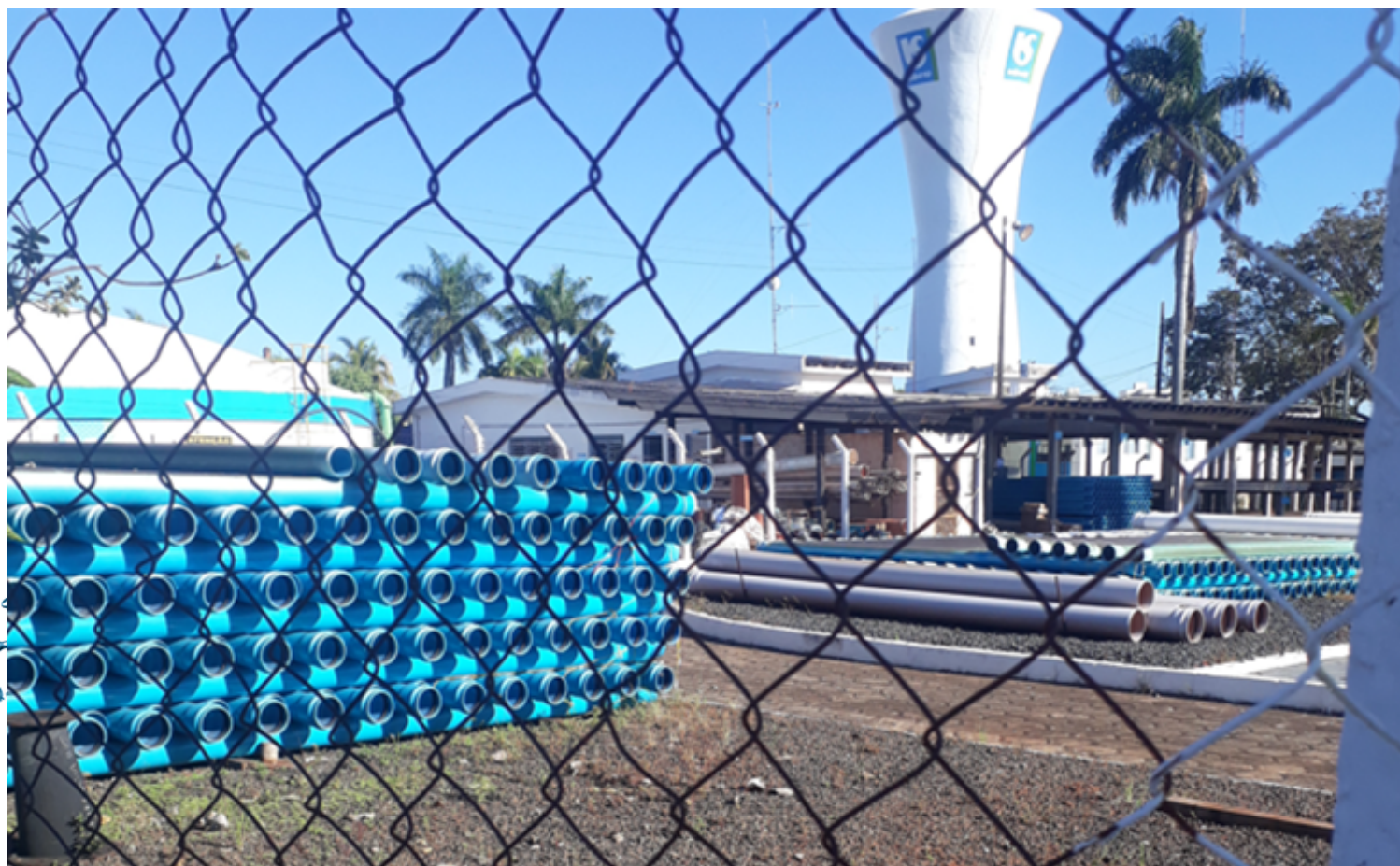
Figura 5 - Tubulações de PEAD, utilizadas para substituição de redes. Sabesp Fernandópolis -SP
