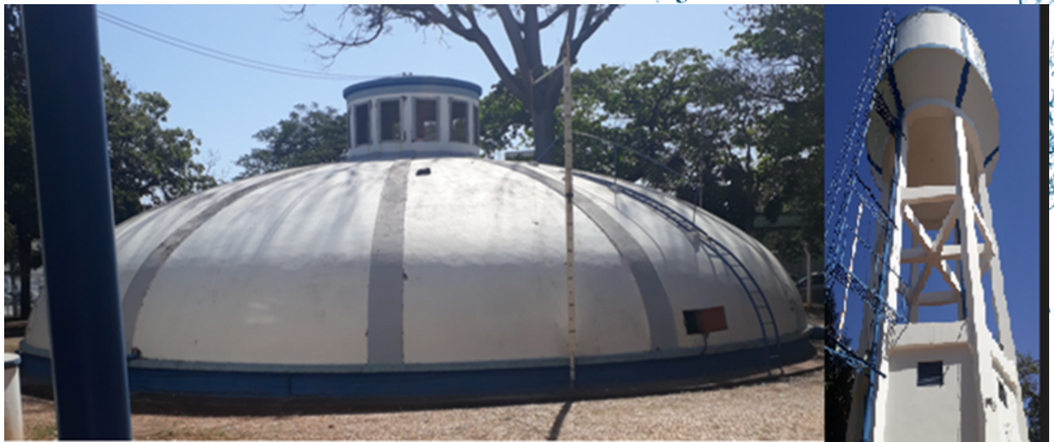
Figura 2 - Reservatório semi-enterrado (abóboda) e Reservatório elevado do SeMAE de São José do Rio Preto
