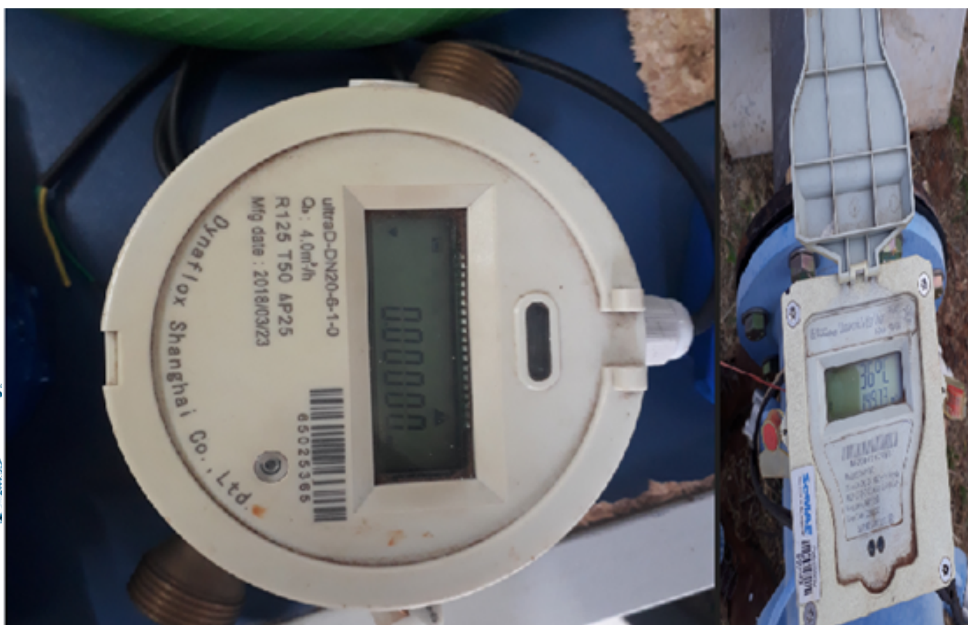
Figura 10 - Macromedidores ultrassônicos utilizados pelo SeMAE de São José do Rio Preto - SP.
