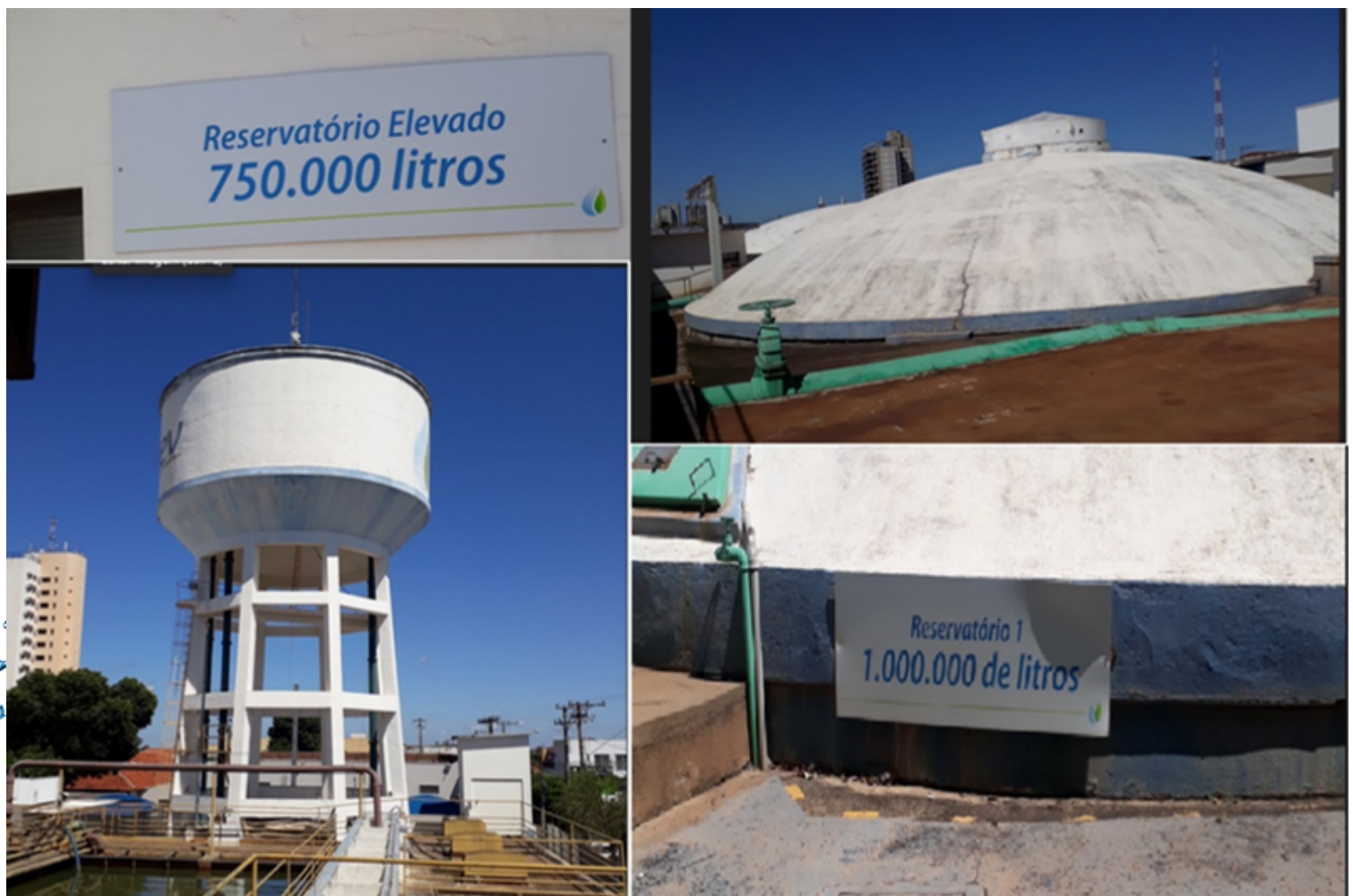
Figura 3 - Reservatório elevado e semi-enterrado (abóboda) do Saev de Votuporanga -SP
