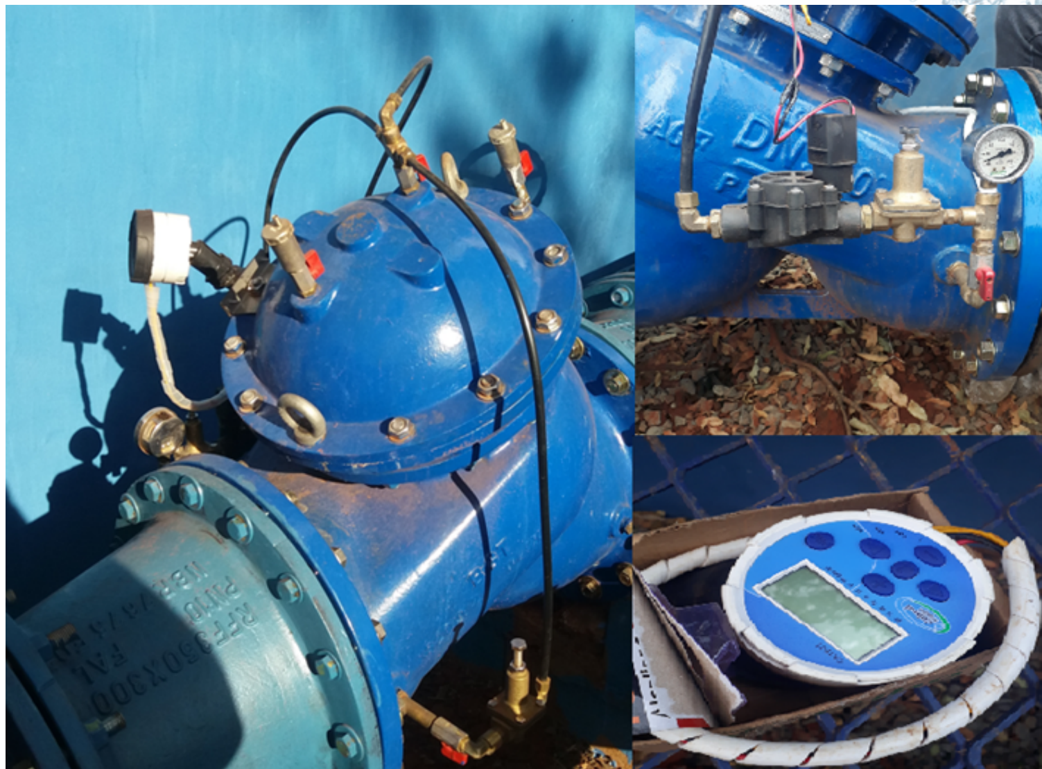
Figura 6 - Modelo de Válvula Redutora de Pressão empregada nas saídas de reservatórios do SeMAE de São José do Rio Preto -SP.
