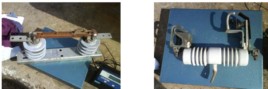
Figura 22 – Chaves cuja parte isoladora é feita de porcelana cinza: (a) faca, (b) fusível.
