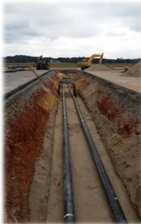
Figura 6 - Construção da nova linha do queroduto para atender ao Terminal 3.
