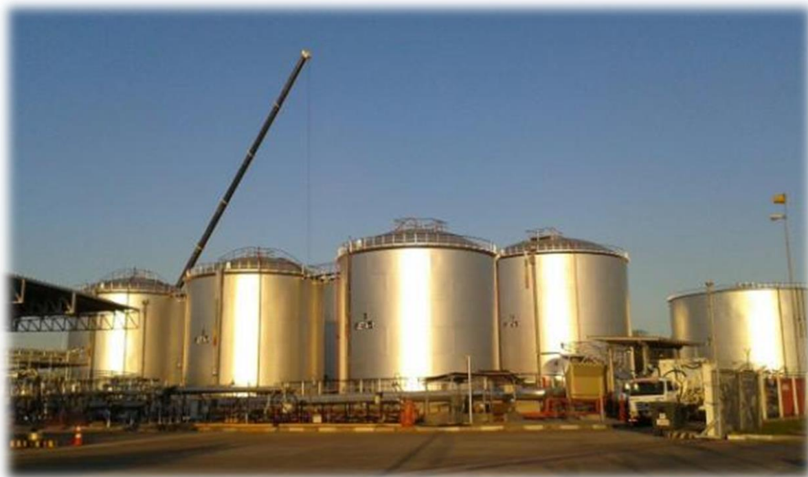
Figura 7 - Central de Combustíveis do Aeroporto Internacional de Guarulhos (CCAIG).
