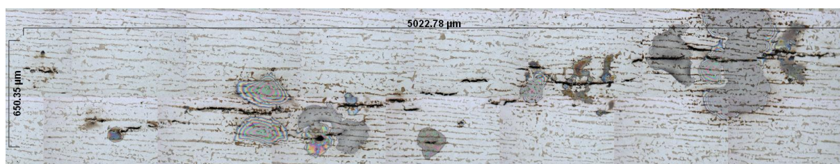
Figura 39 - Trincas em uma das seções do corpo-de-prova 23 exposto a solução 177-B
