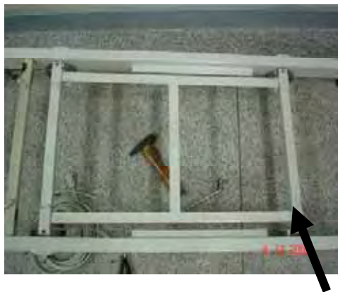
Figura 3.9 – Armação metálica e os quatro suportes metálicos
