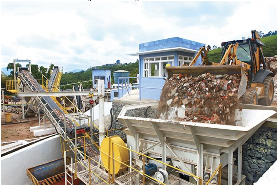
Figura 10 - Reciclagem de RCC em ATT
