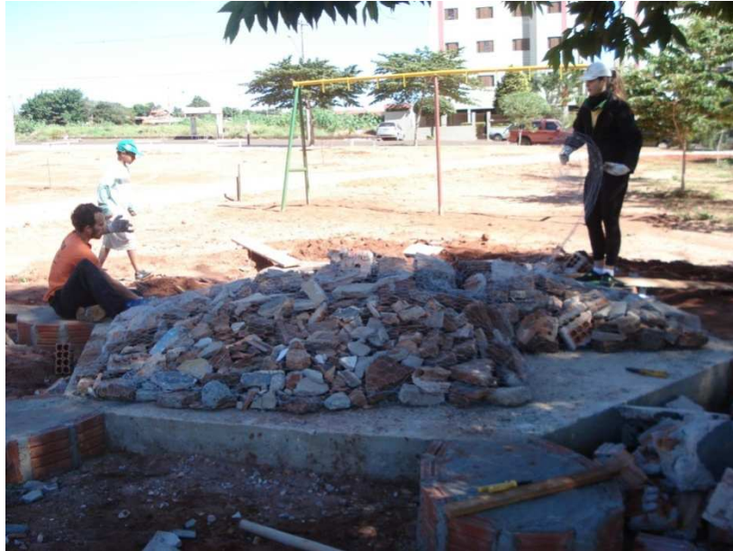
Figura 19. Entulho utilizado para preencher casco da tartaruga gigante.
