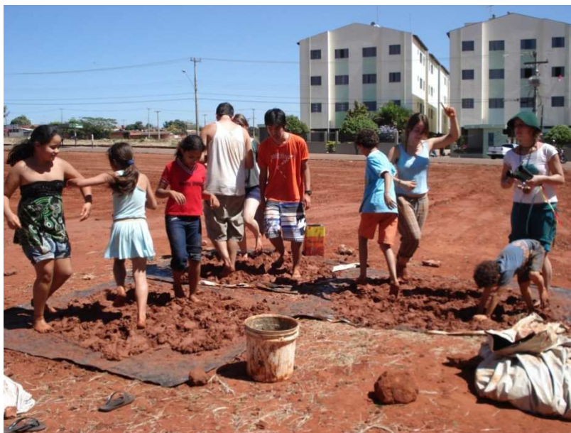
Figura 13. Amassando o barro e fazendo a massa de COB
