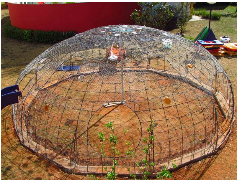
Figura 30. Estrutura em ferro em formato geodésico.
