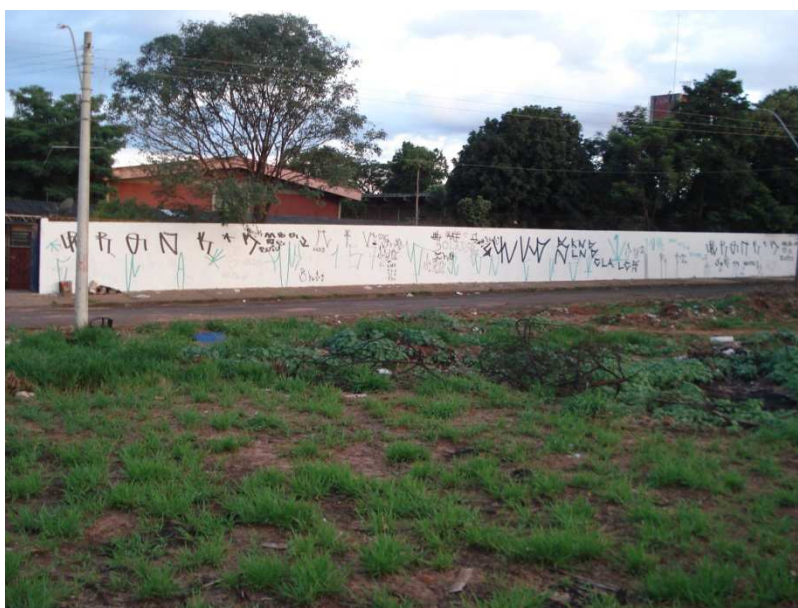
Figura 12. Muro da escola recém-pintado e pichado.
