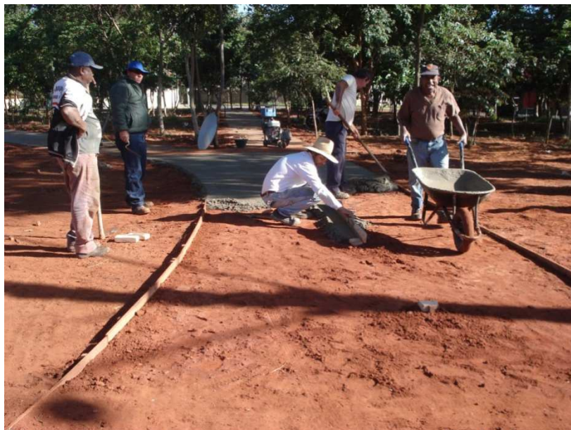
Figura 15. Concretagem das calçadas.
