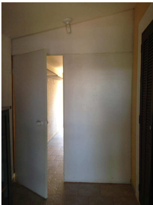
Figura 37. Divisória instalada para a criação do quarto 4.
