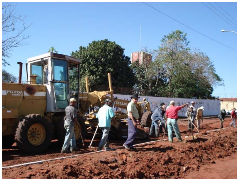
Figura 8. Colocação de guias.
