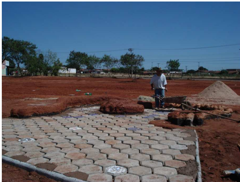
Figura 9. Bioescultura com piso de blocos de concreto.
