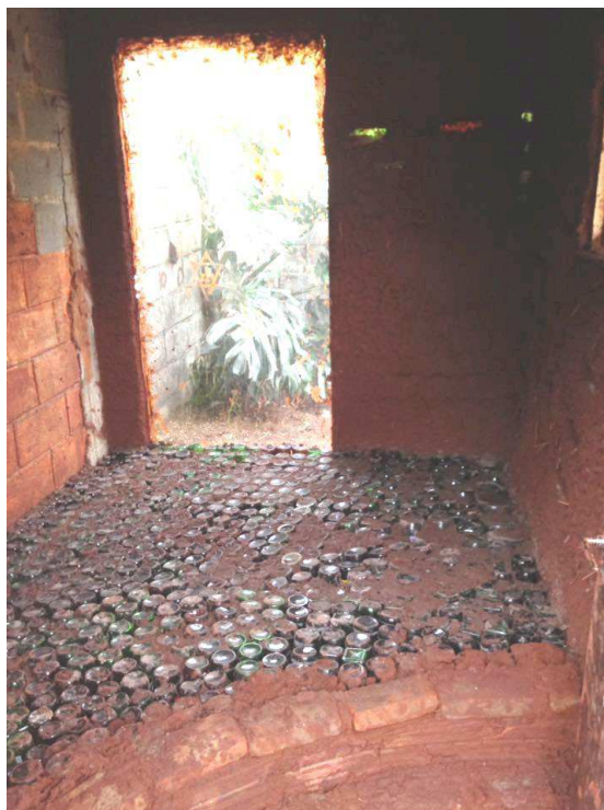
Figura 46. Contrapiso de garrafas.
