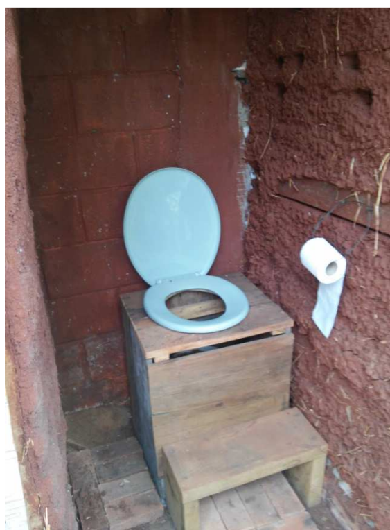
Figura 49. Banheiro seco da Ecocasa Kripa Madhu.
