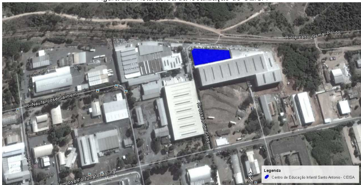
Figura 21. Vista aérea da localização do CEISA
