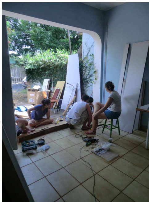
Figura 41. Colocação de divisória fechando a garagem.
