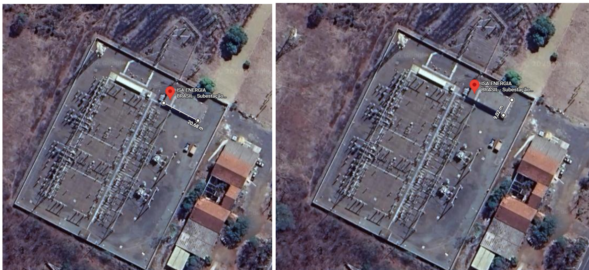
Figura 8 - Medição aproximada de sala de controle.
