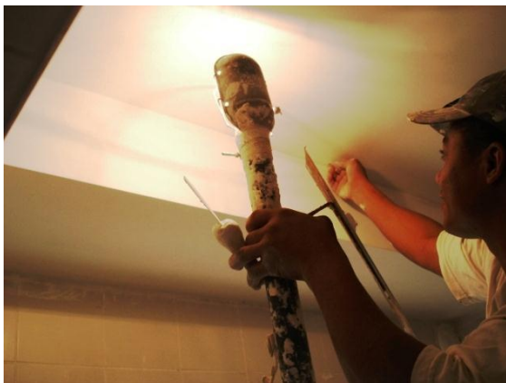
Figura 27: Pintura com auxilio de uma gambiarra
