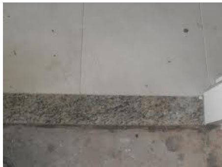
Figura 12: Soleira assentada com massa
