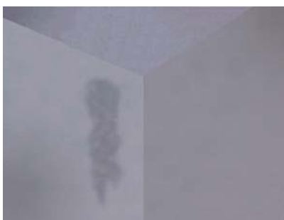
Figura 21: Pintura com escorrimentos de tinta
