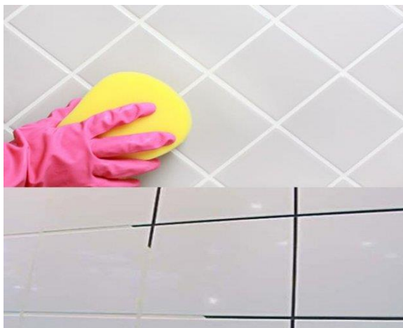
Figura 28: Peças rejuntadas e peças sem rejunte
