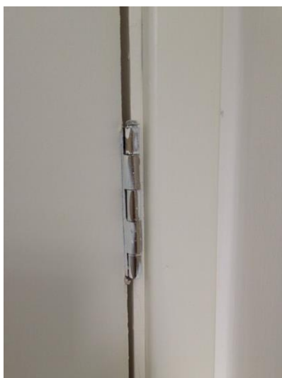
Figura 35: Metal da porta sem proteção e pintado
