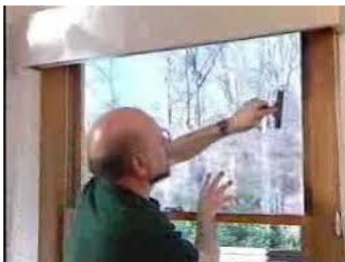
Figura 30: Retirada de bolha da película no vidro
