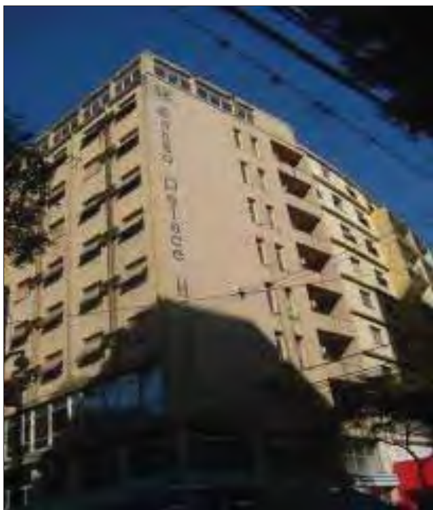
Figura 12: Londrina. Edifício Sahão. 1952 Fonte: SANTOS, 2011
