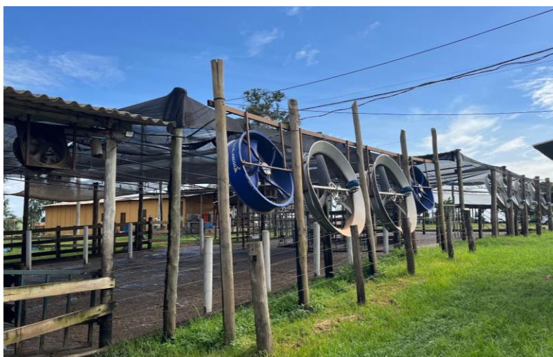
Figura 20 - Salas de resfriamento da Agropecuária Recreio, compostas por aspersores de água e ventiladores laterais.
