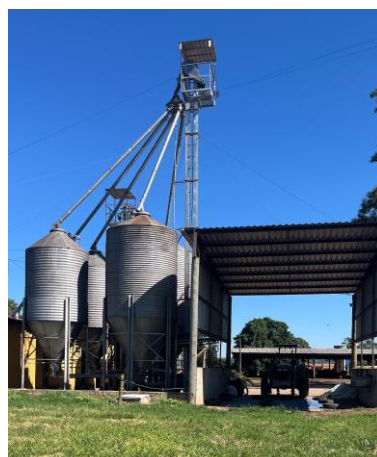
Figura 18 - Fábrica de ração da Agropecuária Recreio em São Carlos/SP.
