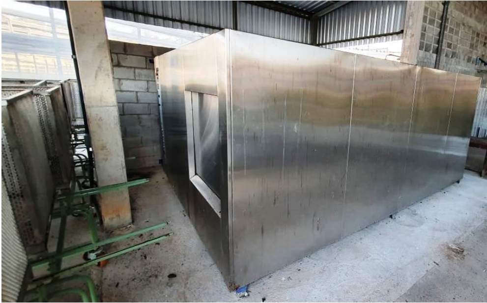
Figura 14 - Câmara de Esterilização de Substrato (CES)
