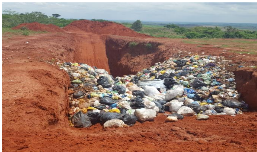
Figura 5 - Resíduos depositados na vala sem recobrimento adequado e ausência de drenagem superficial
