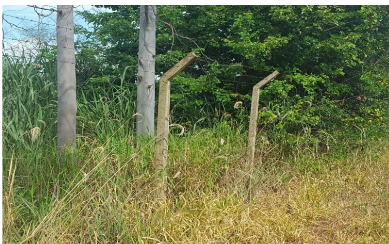
Figura 4: Ausência de isolamento físico
