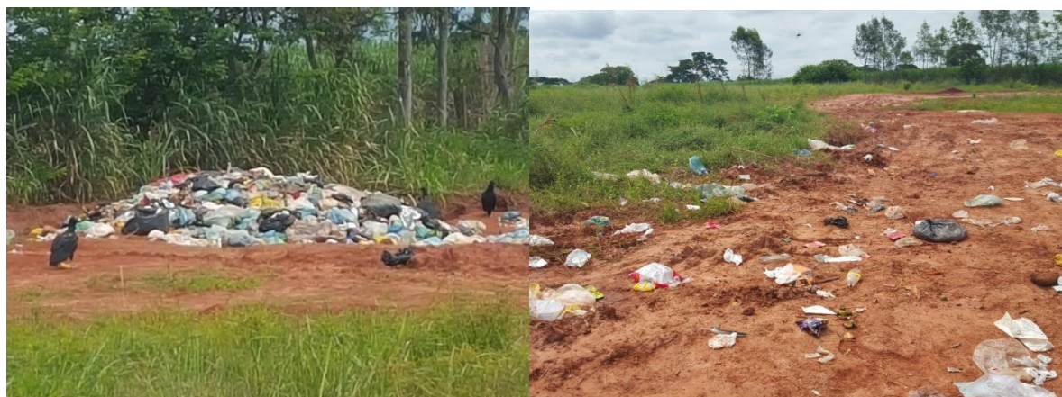
Figura 6: Presença de animais e resíduos sem recobrimento espalhados pelo aterro
