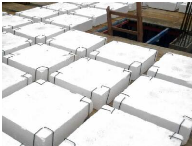
Figura 3 - Nivelamento de lajes.
