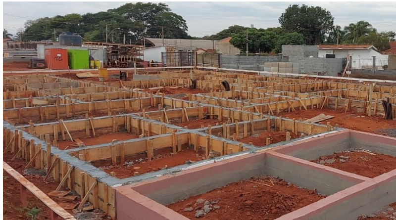
Figura 12 - Forma removível de madeira.
