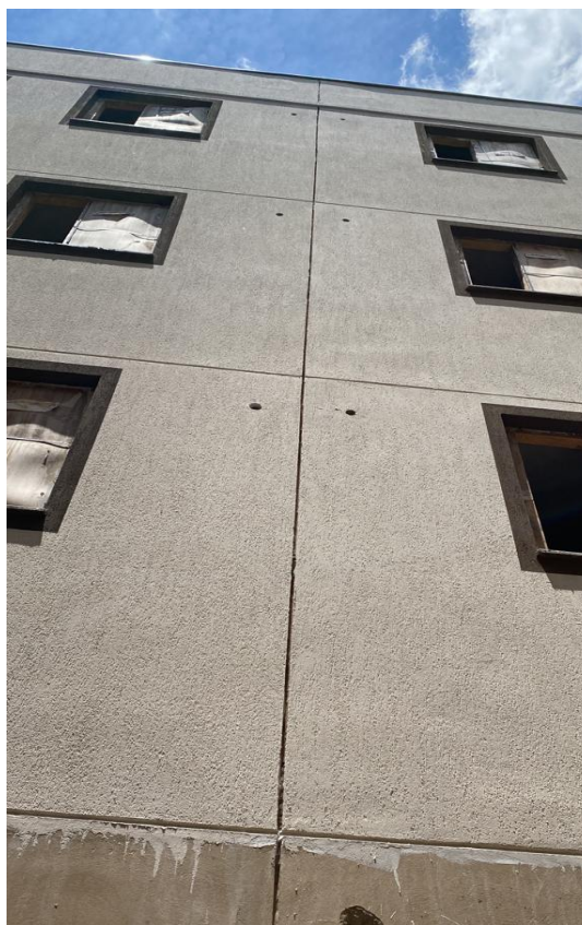
Figura 7 - EPS em junta de dilatação
