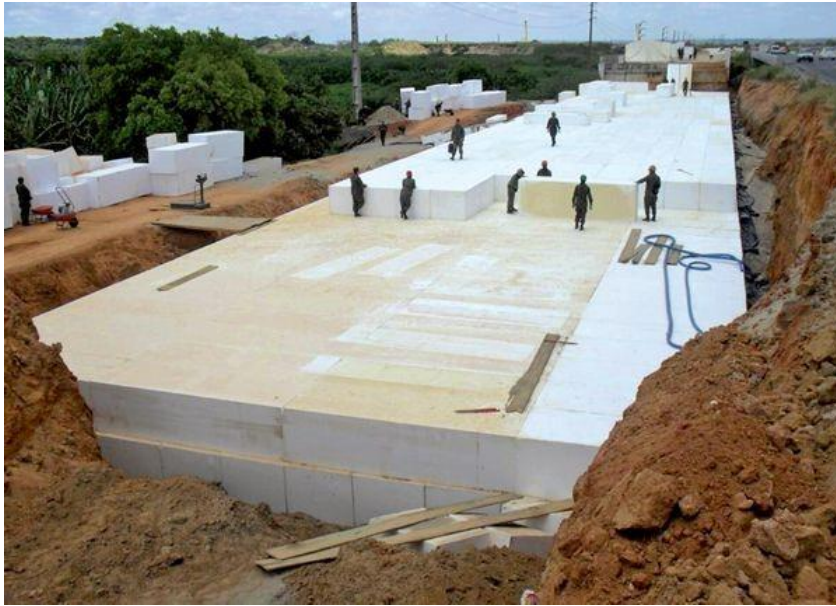
Figura 6 - Aterro para estradas com EPS.
