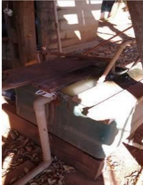
Figura 14 - Fotografia do tanque de equalização
