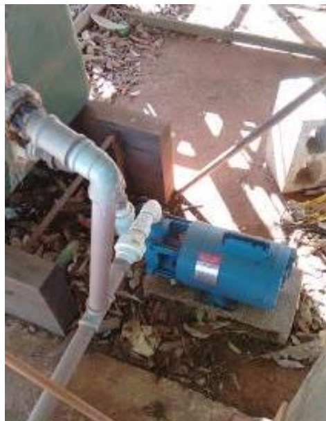
Figura 15 - Fotografia da bomba helicoidal
