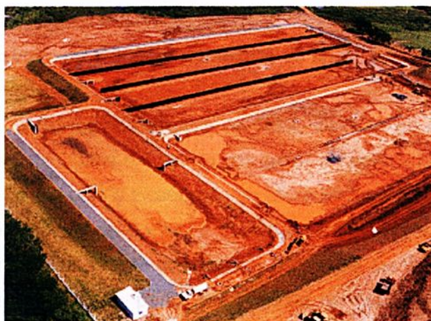
Figura 8 – Vista das obras da ETE de Santa Fé do Sul
