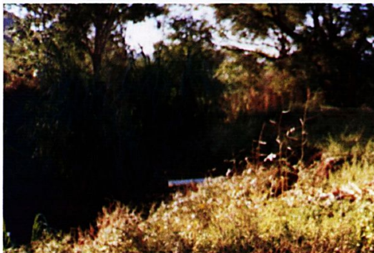
Figura 23 – Tubulação de esgotamento clandestino, descarregando diretamente no Córrego Cabeceira da Mula.
