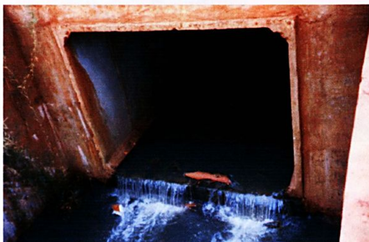
Figura 16 – Local do ponto de coleta 2, no final da canalização, aspecto visual antes da implantação do interceptor e da ETE.
