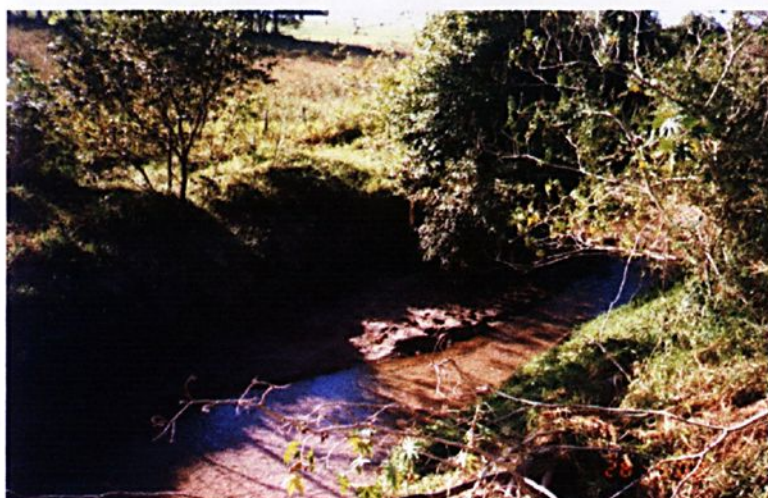
Figura 25 – Aporte de material no fundo do Córrego.
