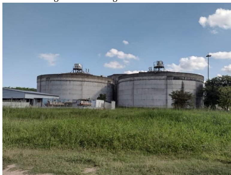
Figura 11 - Vista geral de dois digestores anaeróbios da ETE Barueri
