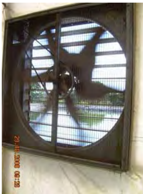
Foto 7. Exaustor, conhecido como Fan, é acionado automaticamente quando a temperatura da estufa atinge 28 °C.
