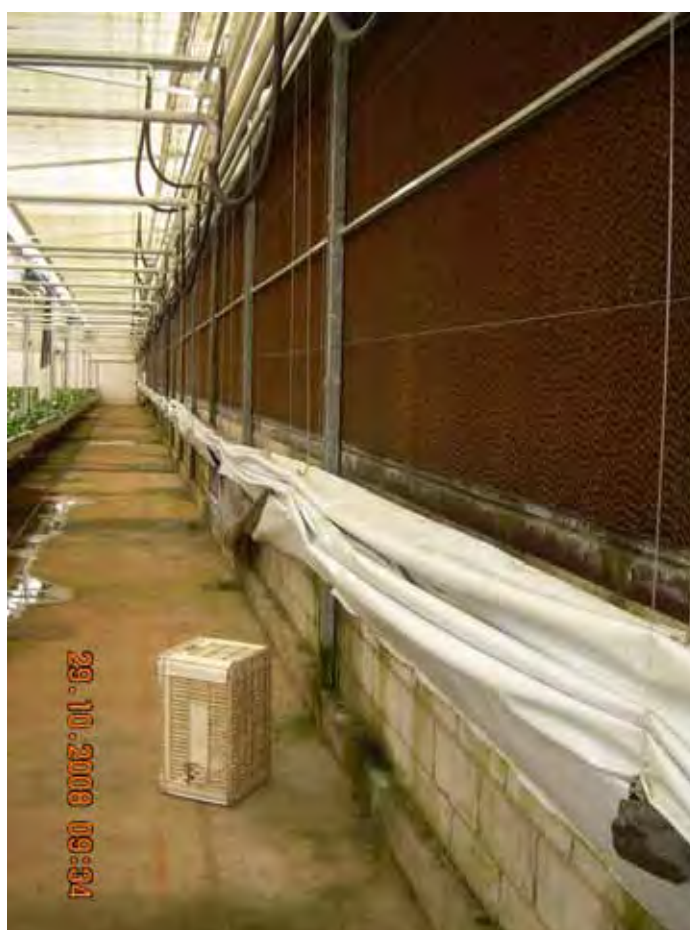
Foto 9. A parede contrária ao exaustor é uma parede úmida, ou seja, É feita de papelão ondulado, por onde escorre água quando o exaustor é acionado. No momento em que o exaustor é acionado, a cortina plástica desce automaticamente, para que o ar externo possa entrar.
