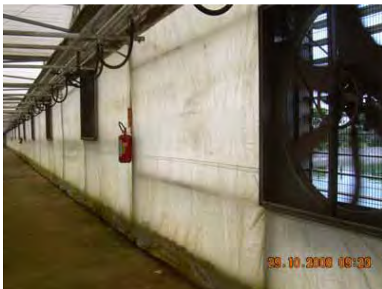
Foto 8. Em cada vão de estufa existe um exaustor.
