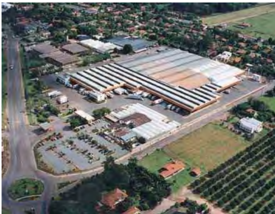
Foto Aérea 1. Cooperativa de distribuição de flores e plantas, localizadas no centro do município. No local são vendidas as plantas dos sócios e feita a distribuição entre os compradores. FONTE: www.veiling.com.br em 15 de Junho de 2008.
